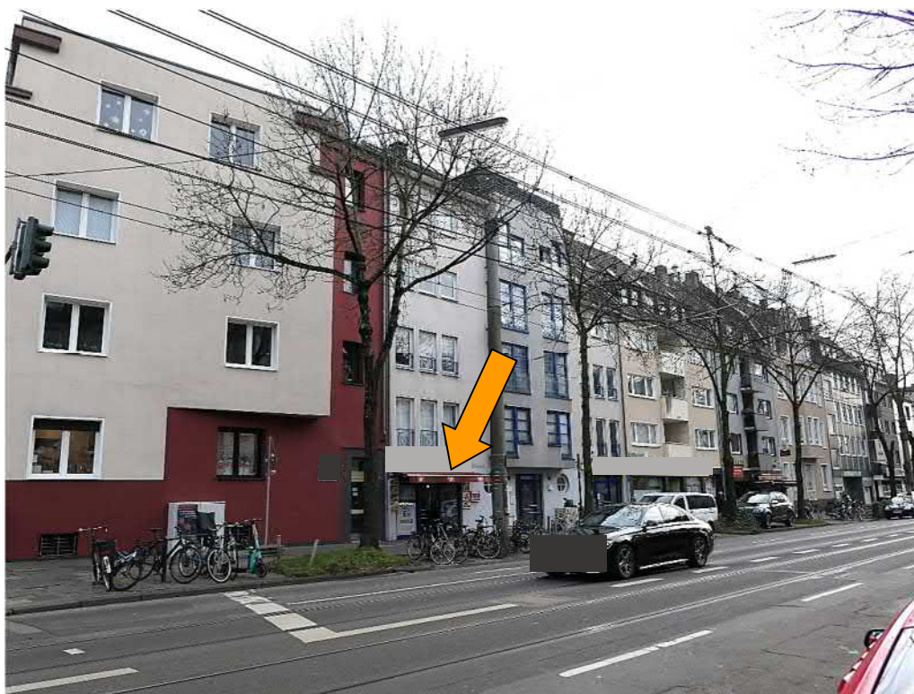
Straßenansicht von Nordwesten
