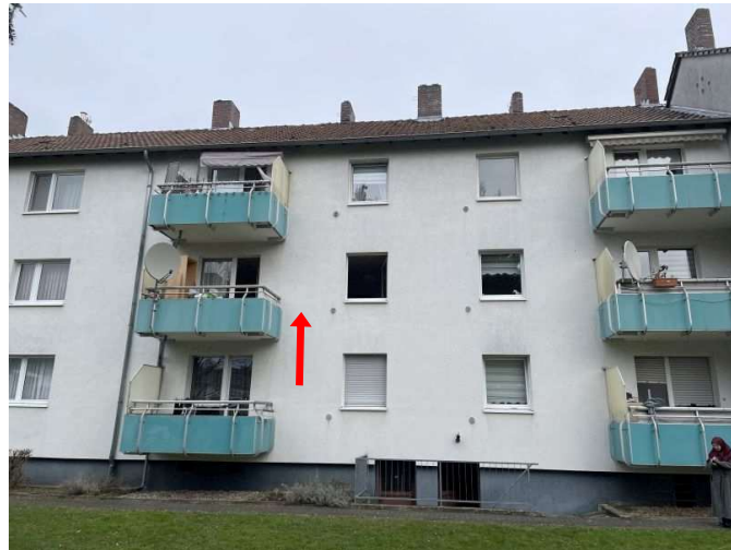
Rückwärtige Ansicht mit Wohnung Nr. 48 im 1. OG rechts
