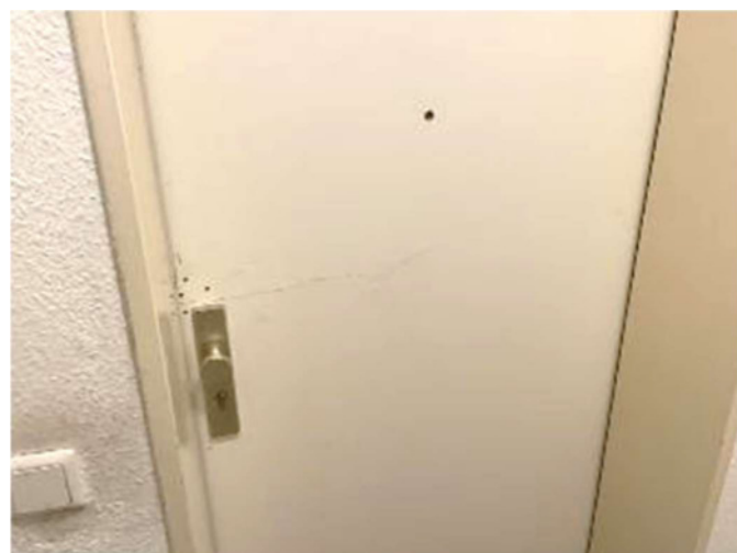
Eingangstür Wohnung Nr. EM 5 im 1. Obergeschoss links
