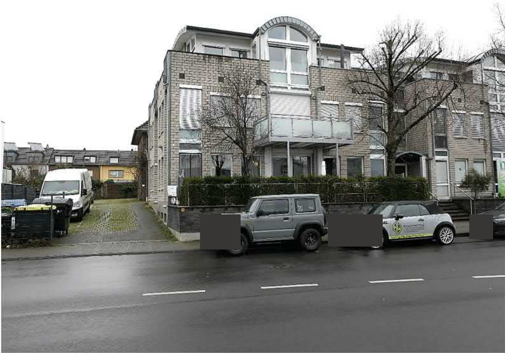
Straßenansicht Bürogebäude mit Zufahrt zum hinteren Grundstück
