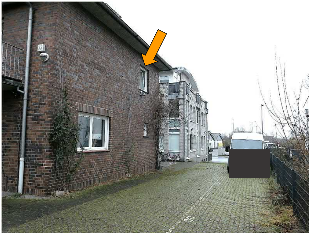
Ansicht Altbau mit seitlicher Zufahrt/Stellplätzen
