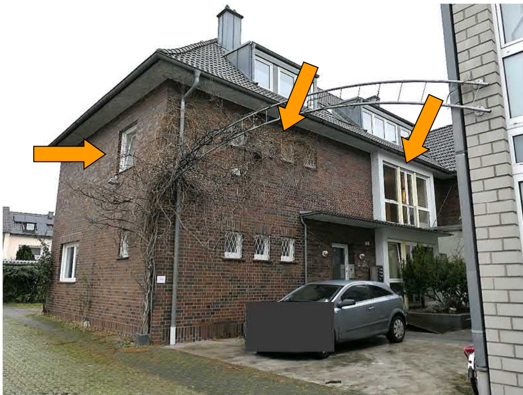
Ansicht Altbau auf dem hinteren Grundstück
