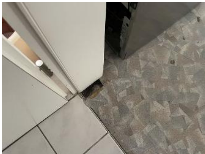
Unsauberer Bodenbelagabschluss
