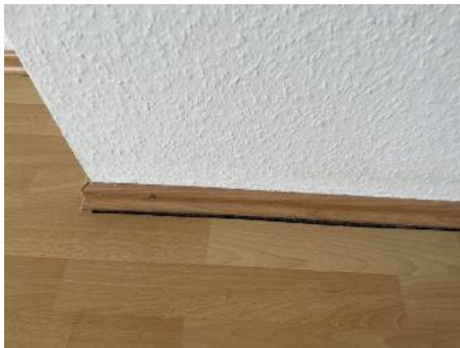
Unsauberer Bodenbelagabschluss
