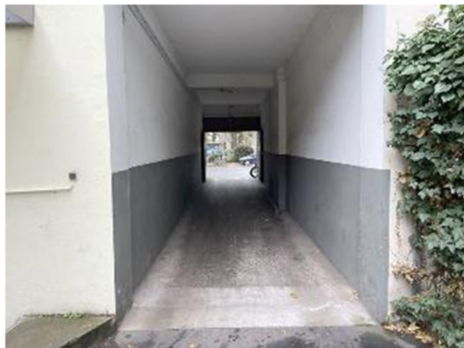
Durchfahrt von der Roonstraße zur Hoffläche
