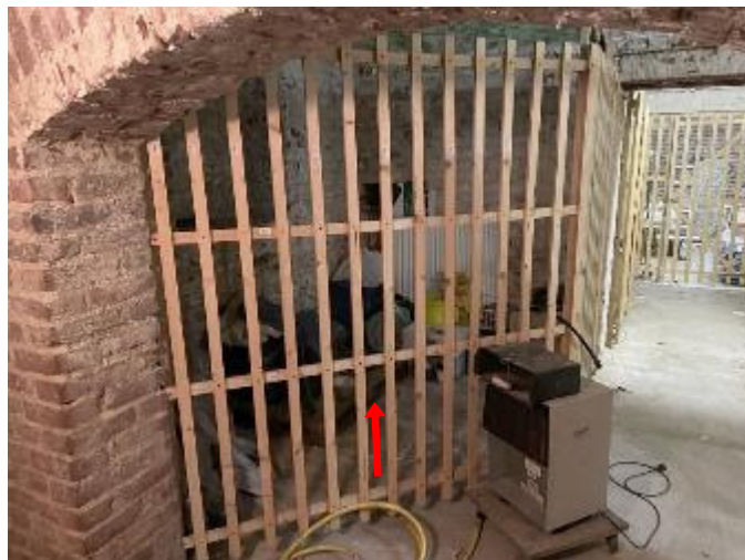
Kellerraum Nr. 14 im Kellergeschoss
