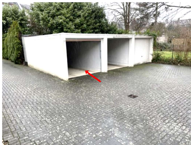
Pkw-Garagen Nrn. ST 11, ST 12 und ST 13
