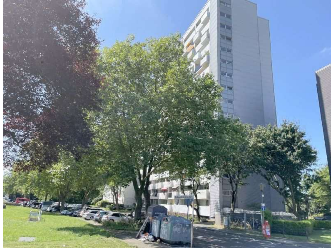
VI-geschossiges Hochhaus Robert-Schuman-Straße 2, 4
