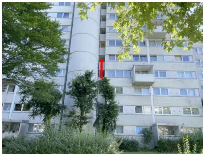
Westansicht mit Eingang zur Wohnung Nr. 4/3 im 4. OG
