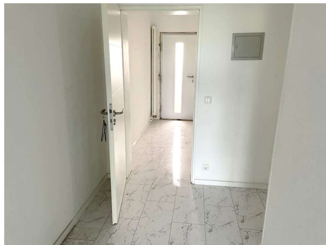
Flure und Eingangstür der Wohnung Nr. 4/3 im 4. Obergeschoss
