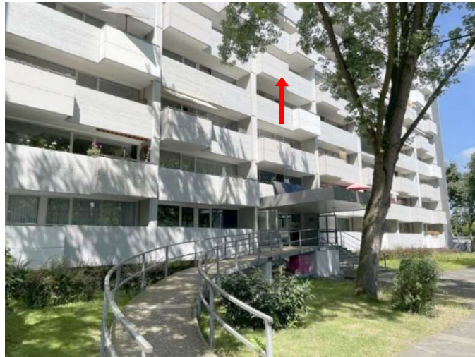
Rampe zum Hauseingang
