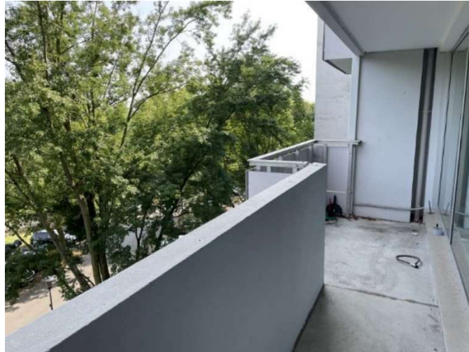
Loggia I der Wohnung Nr. 4/3 im 4. Obergeschoss
