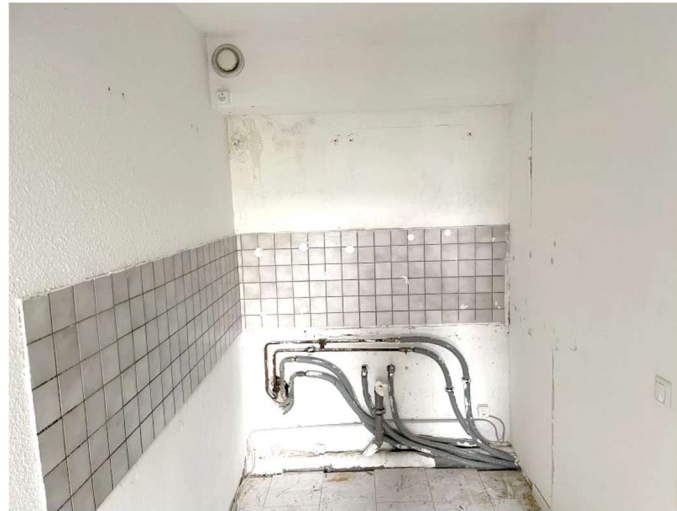
Küche in der Wohnung Nr. 4/3 im 4. Obergeschoss
