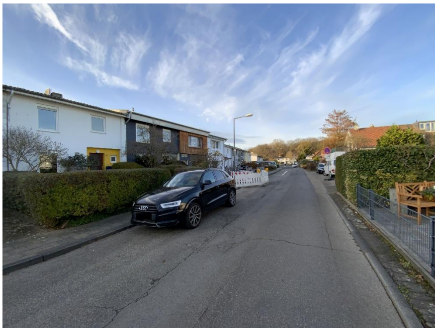
Bild 22: Nachbarbebauung – Berner Straße Richtung Norden
