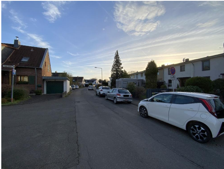
Bild 21: Nachbarbebauung – Berner Straße Richtung Süden
