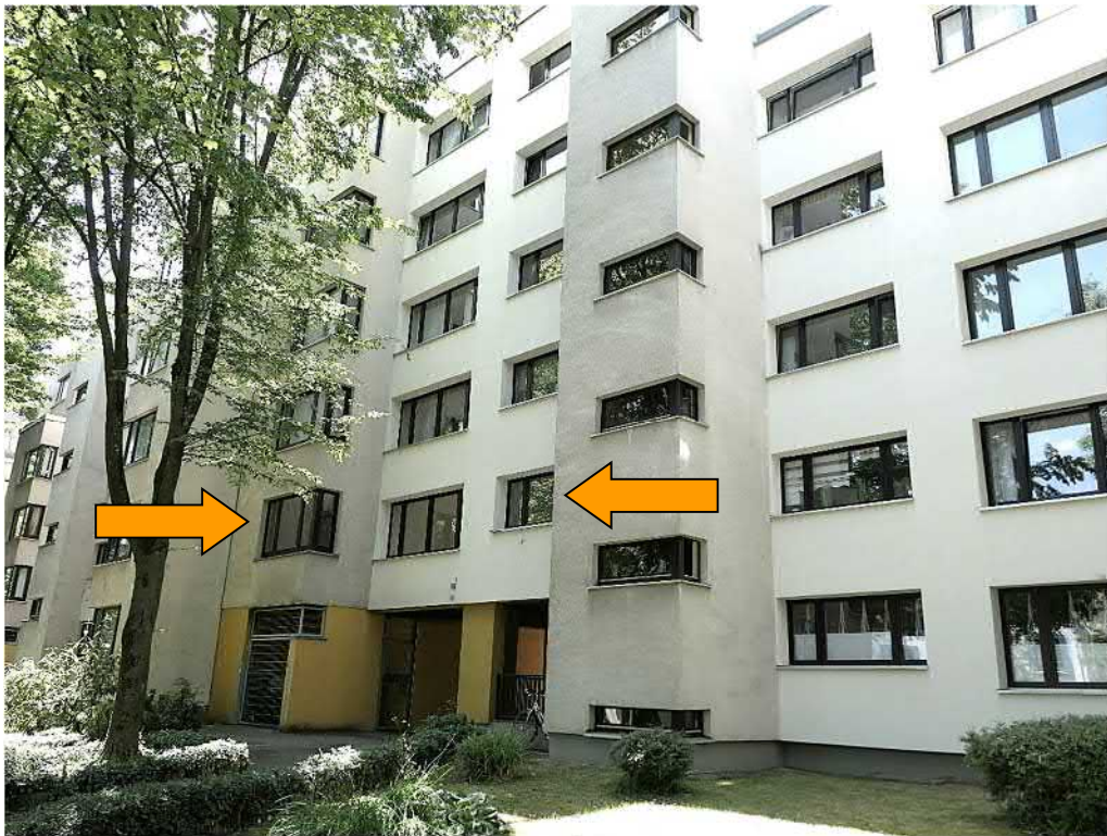
Straßenansicht von Norden
