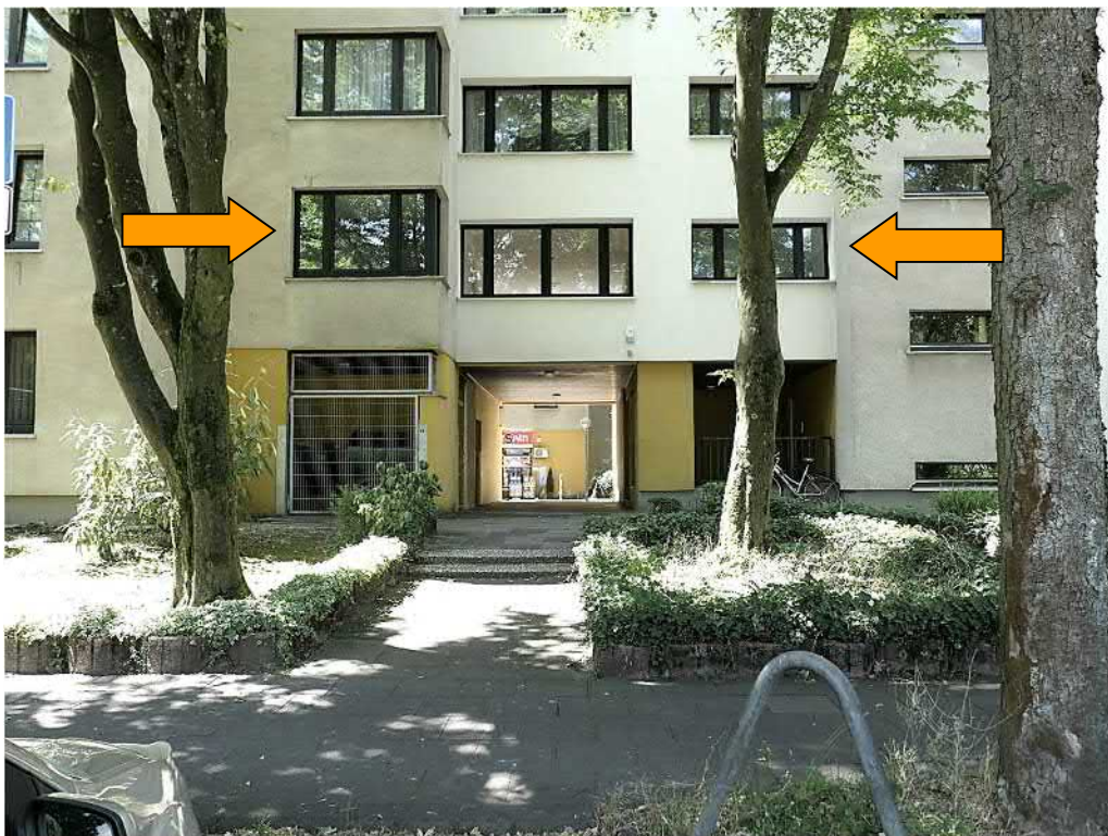
Straßenansicht von Nordosten
