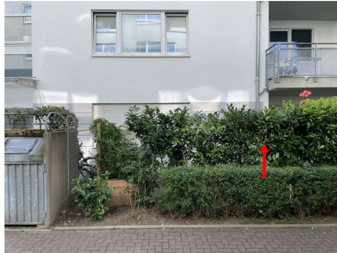
Wohnung Nr. 1 im Erdgeschoss vorne rechts
