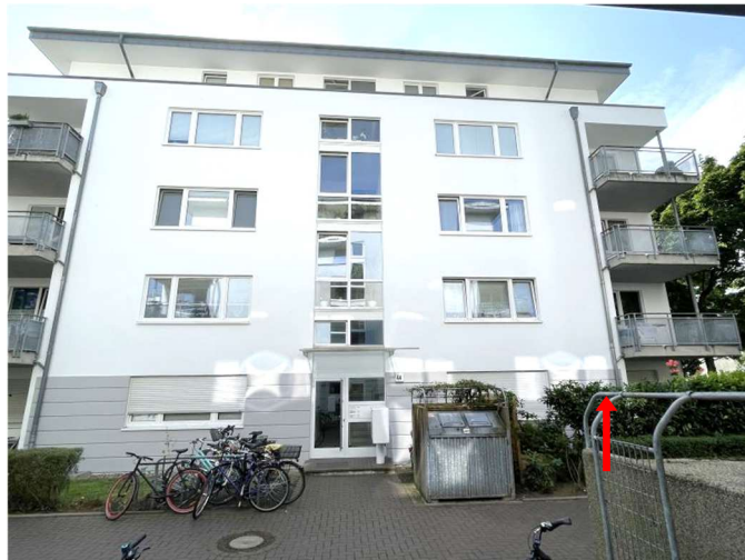
Straßenansicht mit Hauseingang und Wohnung Nr. 1 im EG
