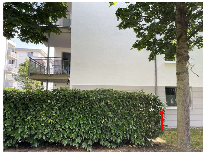
Südansicht mit Wohnung Nr. 1 im Erdgeschoss vorne rechts
