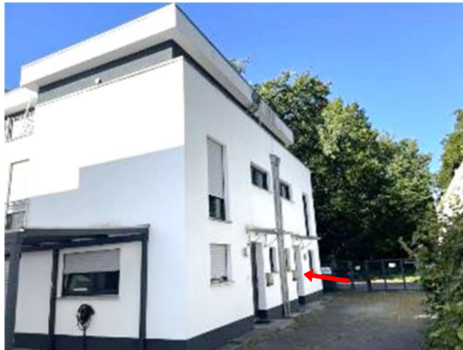
Doppelhaus Bilsteiner Straße 7, 9
