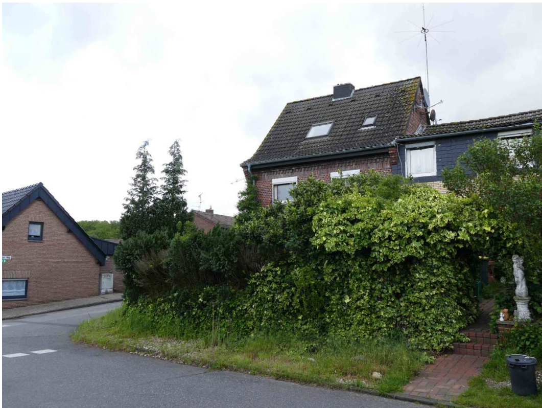
Bild 1: Frontansicht Reihenendhaus (Blick nach Nordosten)
