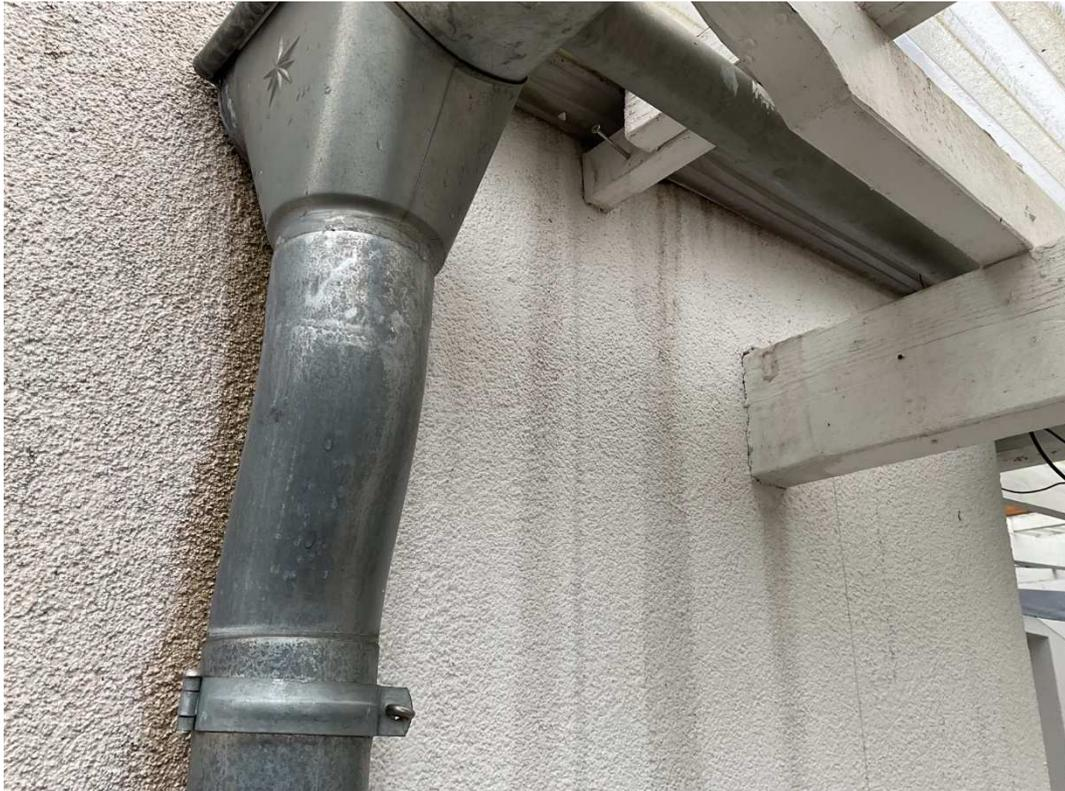
Bild 8: unfachmännisch ausgeführte Anschlüsse Überdachung an Fassaden, hier exemplarisch an einer Stelle
