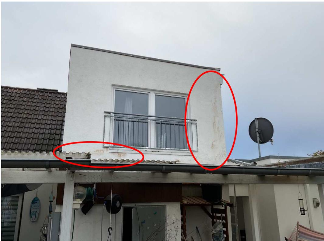
Bild 9: Aufweichung Fassade
