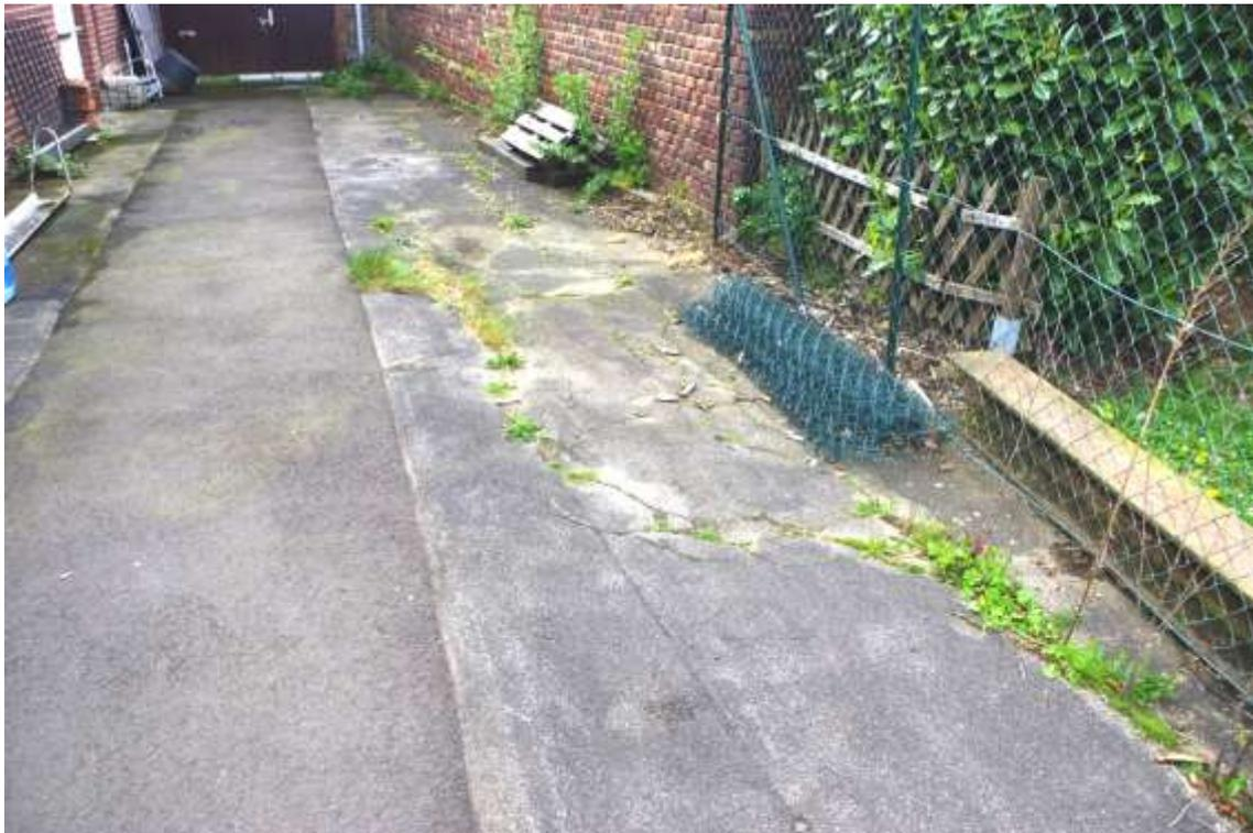
Bild 5: Detailansicht der rissigen Bitumenasphaltfläche
