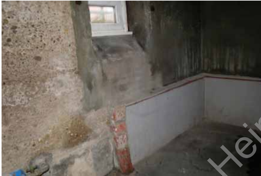
Speicher Spitzbodengeschoss (Wohnhaus LP Nr. 1 / Vorderhaus)
