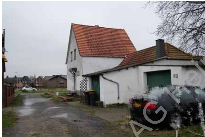
Ansicht vom Wirtschaftsweg (Wohnhaus LP Nr. 1, Nebengebäude 2)
