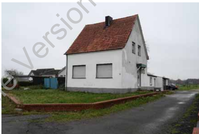
Straßenansicht (Wohnhaus mit Nebengebäuden LP Nr. 1 + 2)
