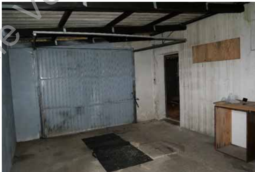
Geräteschuppen Erdgeschoss (Nebengebäude LP Nr. 2)
