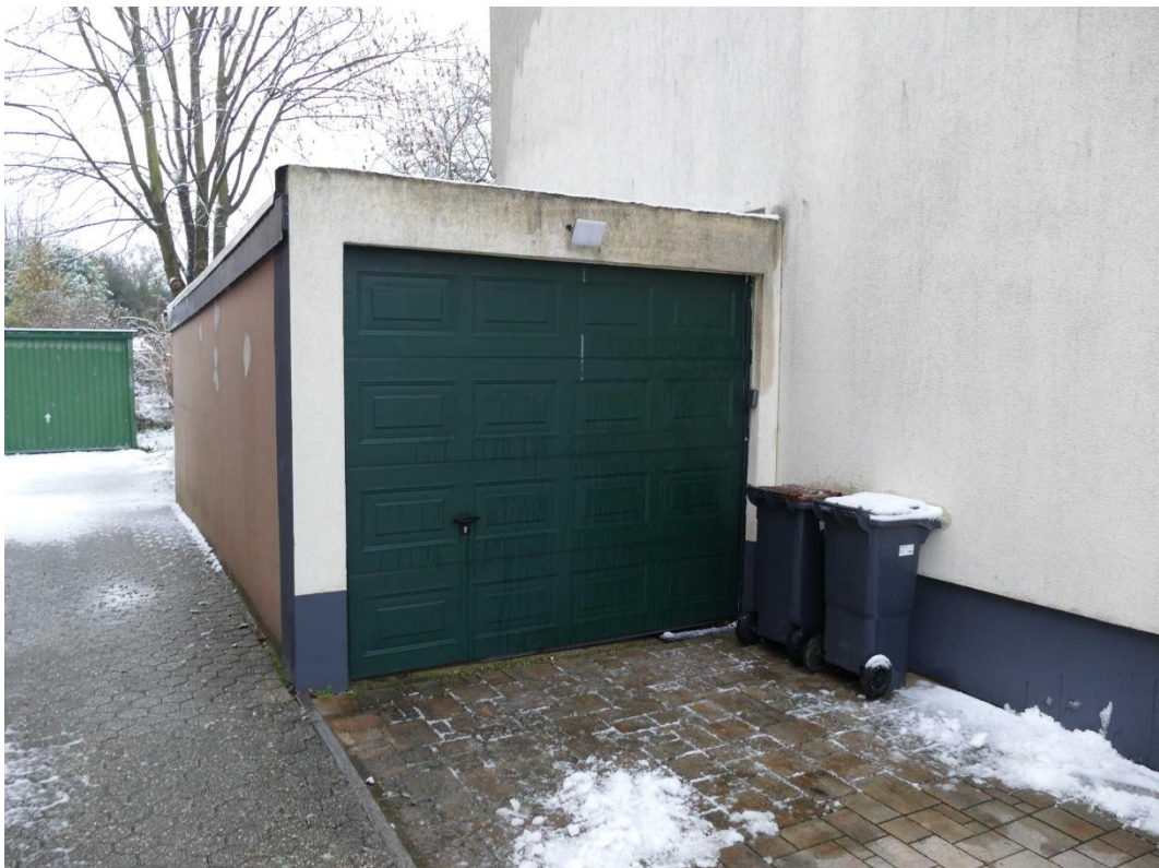
Bild 5: Garage Frontansicht (Blick nach Norden)
