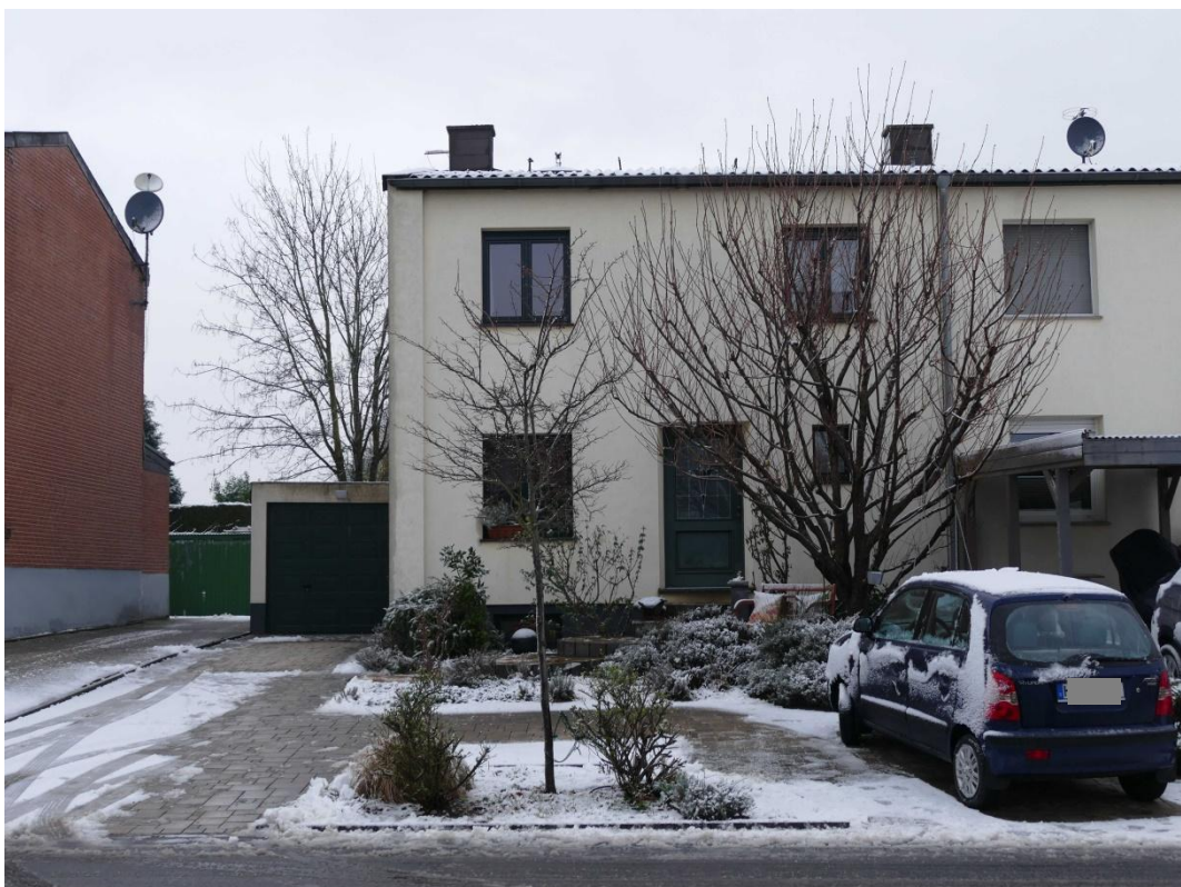
Bild 1: Frontansicht (Blick nach Norden)
