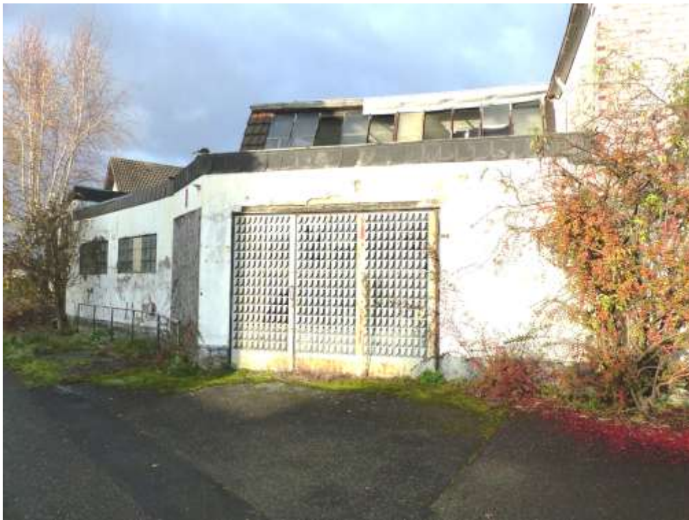
Bild 5: Ansicht des Werkstattgebäudes
