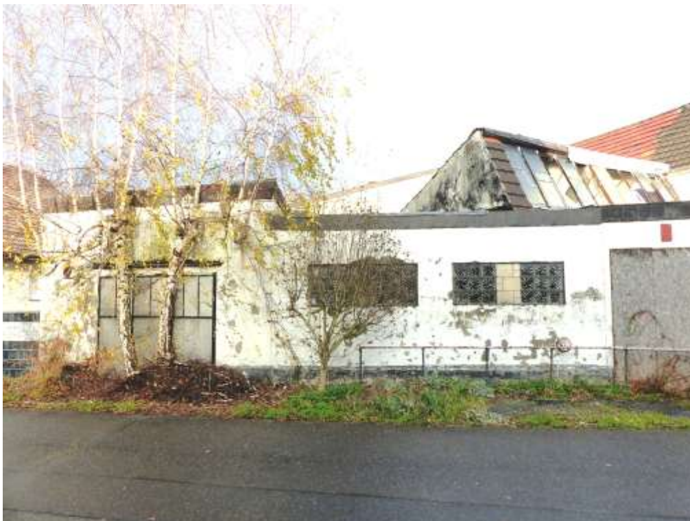
Bild 6: Ansicht der aufstehenden Bebauung aus West
