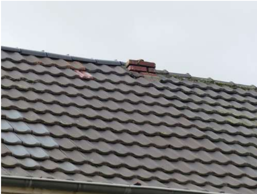
Bild 14: Detailansicht Dachflächen und Kaminkopf
