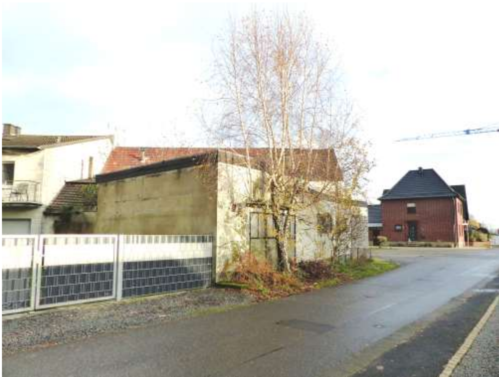
Bild 7: Ansicht des Bewertungsgrundstücks aus Nordwest
