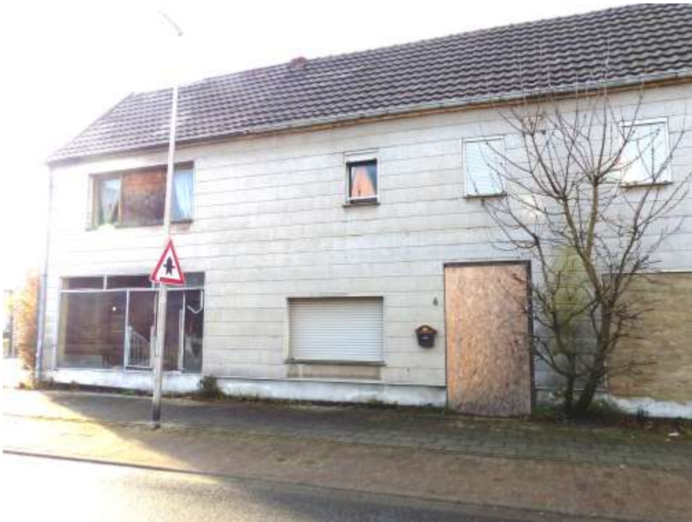
Bild 3: wie vor, Detailansicht
