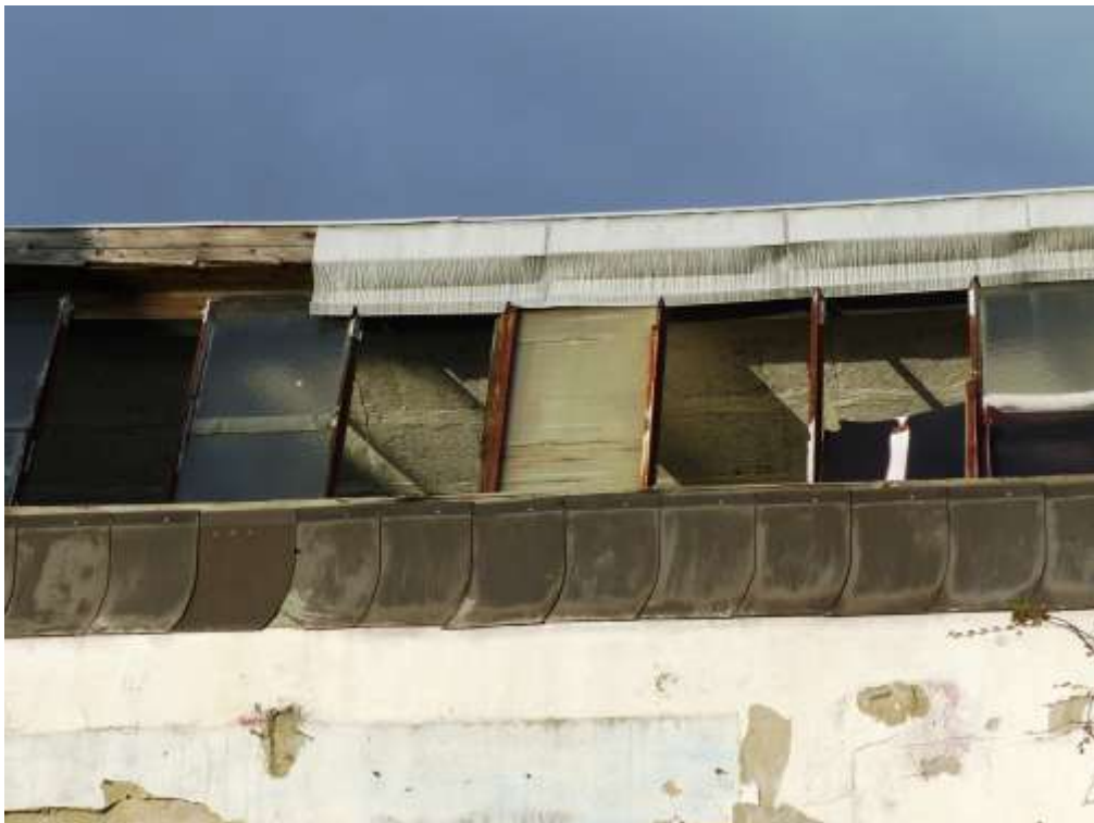
Bild 15: Detailansicht Lichtband im Sheddachbereich der Werkstatt
