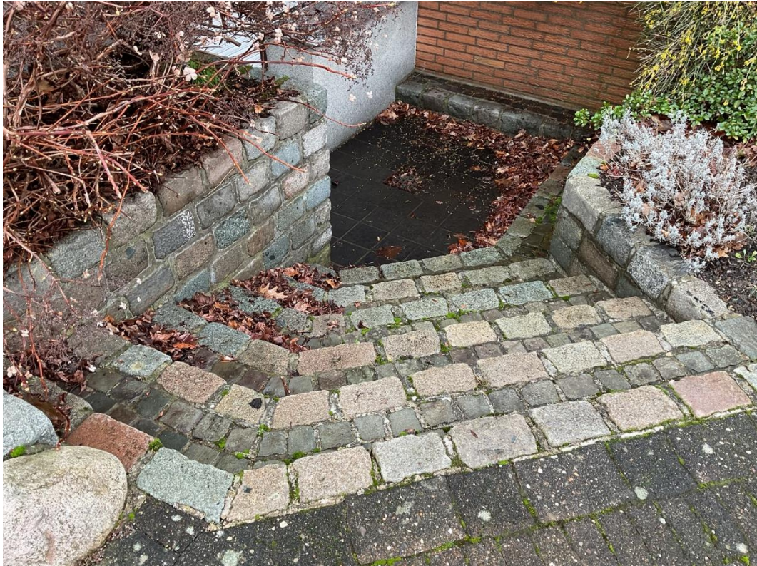
Bild 4: Abgang zu Kellerraum
