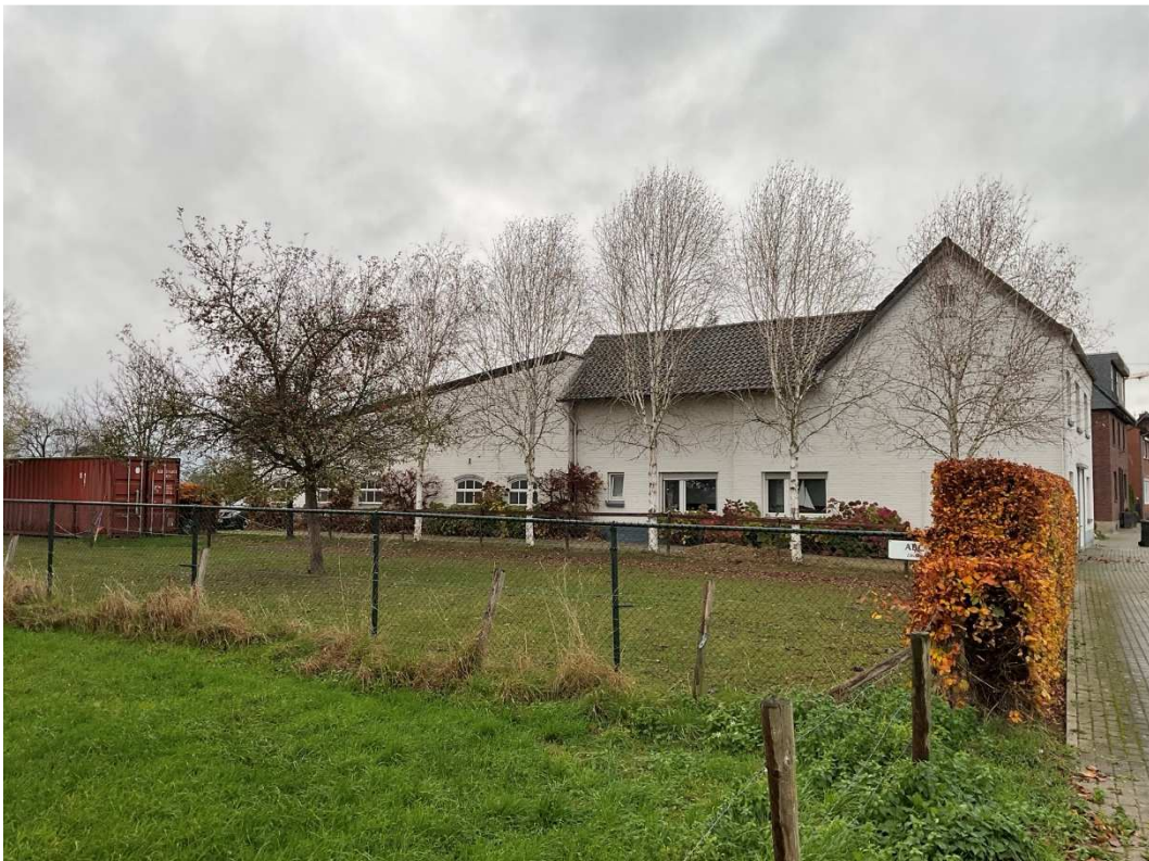
Bild 3: Seitansicht Wohnhaus mit Anbau und Scheune
