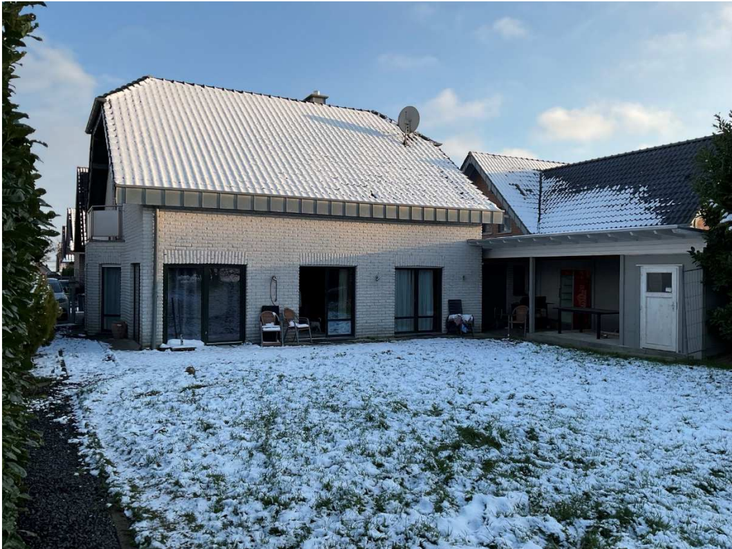
Bild 4: Rückansicht Einfamilienwohnhaus und seitlicher Schuppen
