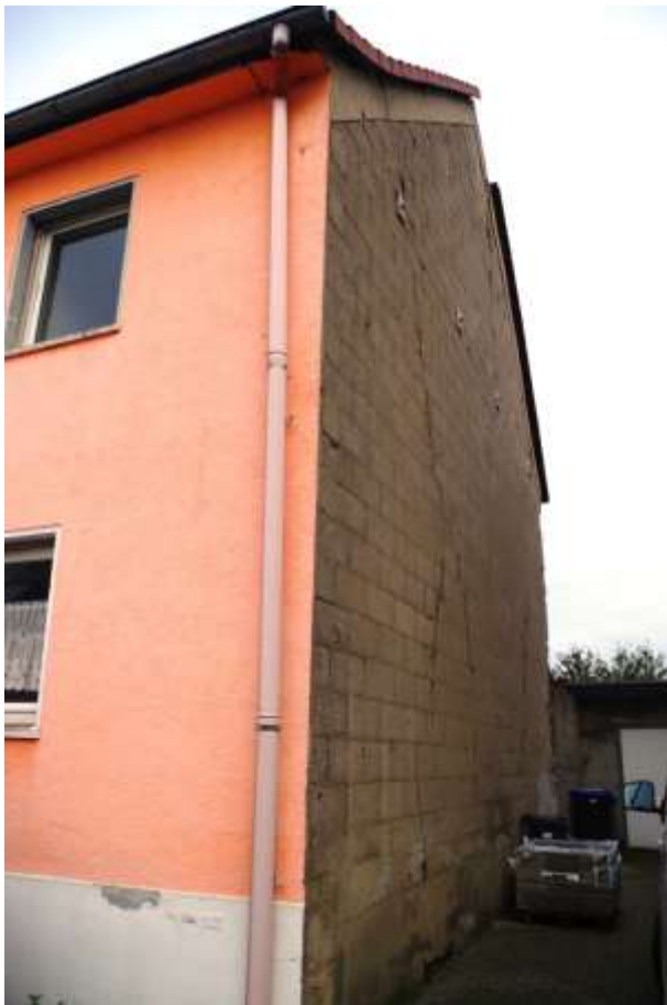
Bild 3: Giebelansicht des Einfamilienhauses
