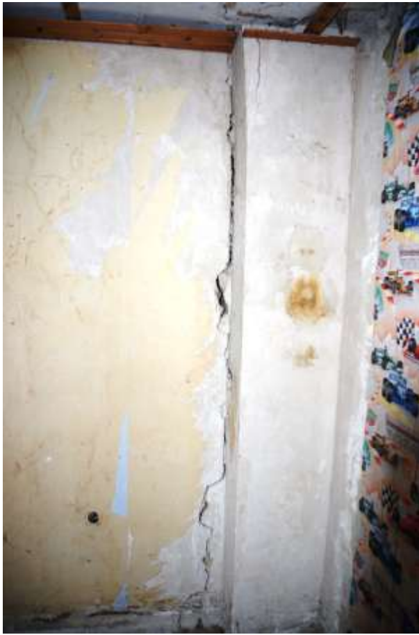
Bild 31 und Bild 32: Detailansicht Risse in Wand- und Deckenbereich (OG)
