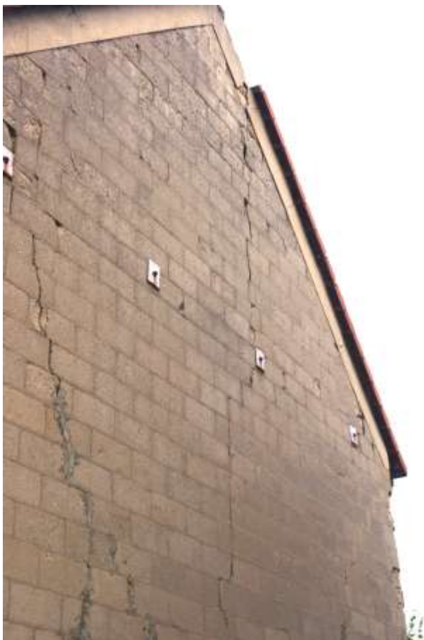
Bild 33 und Bild 34: Ansicht der Gebäuderisse (giebelseitig)
