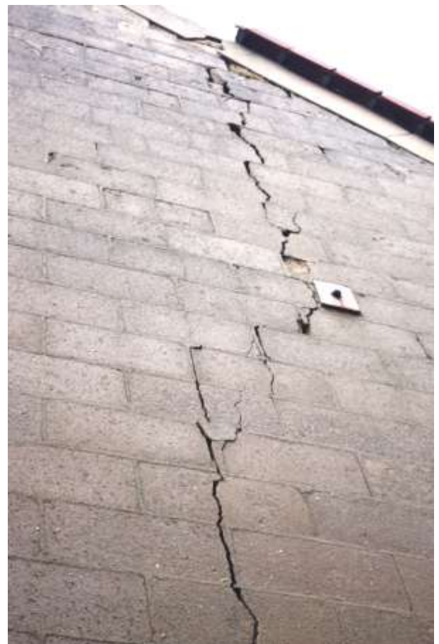
Bild 33 und Bild 34: Ansicht der Gebäuderisse (giebelseitig)
