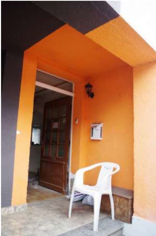
Bild 9: Detailansicht des Hauseingangs
