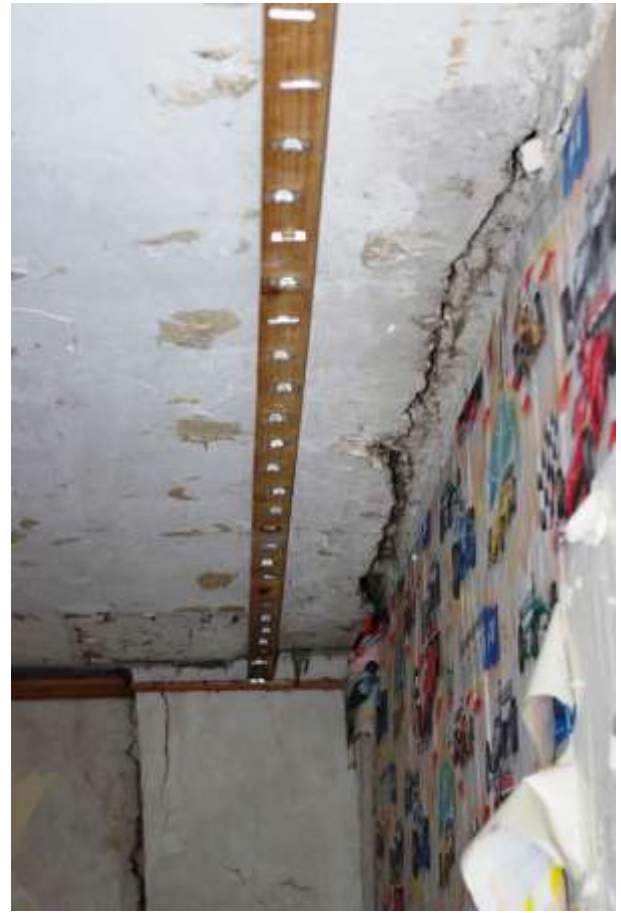
Bild 31 und Bild 32: Detailansicht Risse in Wand- und Deckenbereich (OG)
