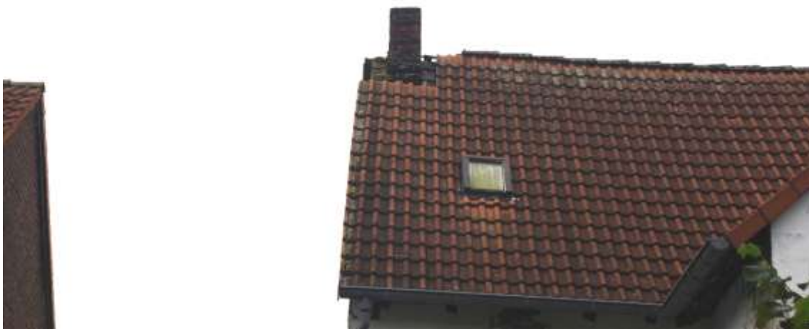
Bild 28: Ansicht offenes Dach im Kaminbereich
