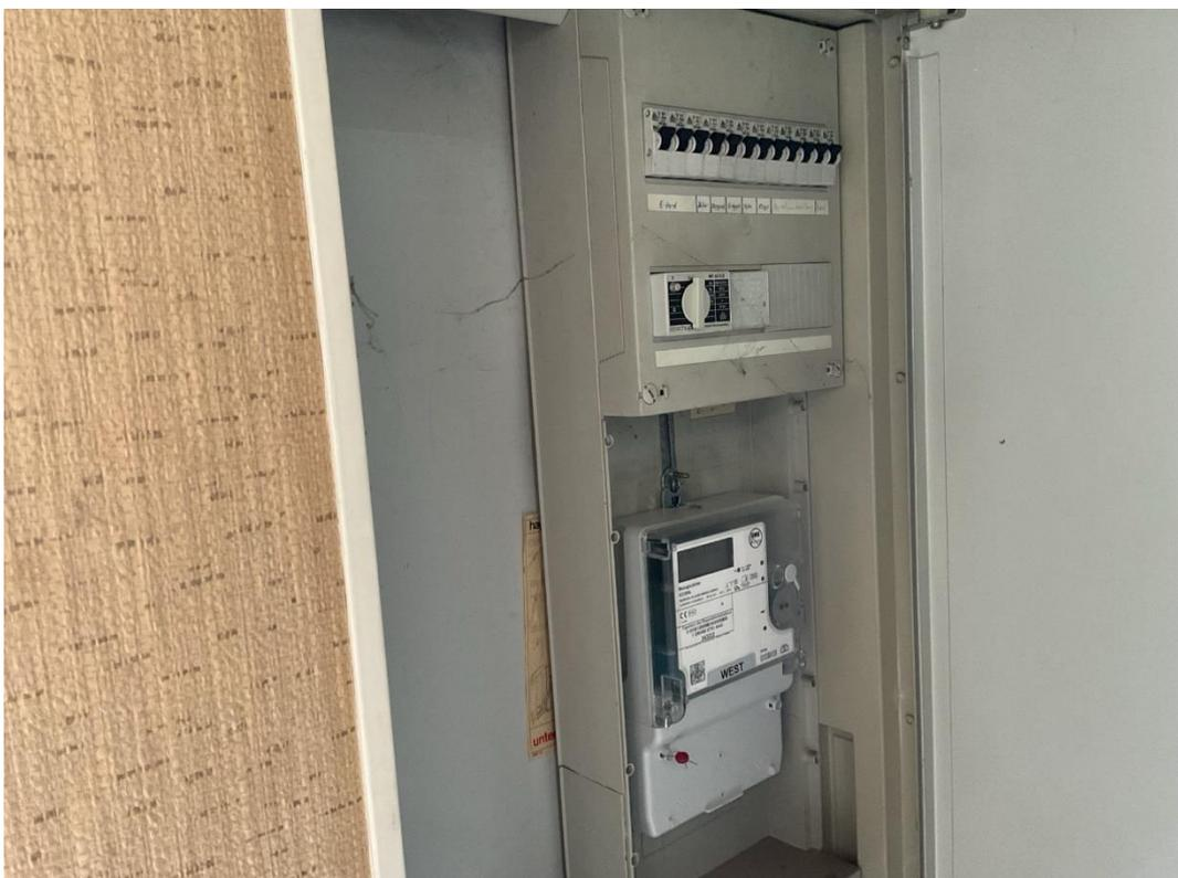
Bild 19: Zählerschrank/ Elektroabsicherung
