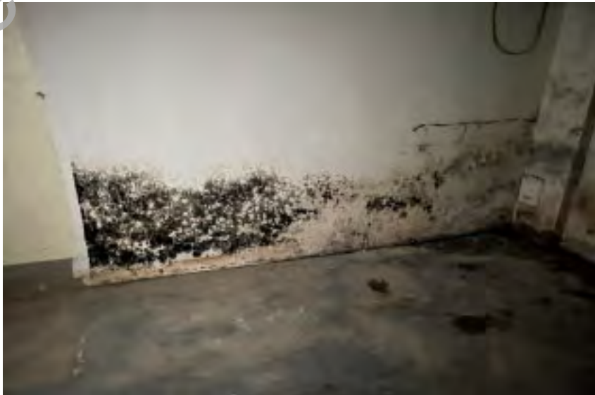
Keller 2 Kellergeschoss (Wohnhaus LP Nr. 1) mit starkem Schimmelschaden
