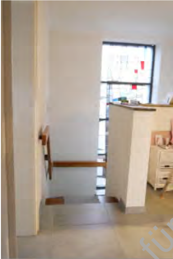
Treppe Obergeschoss (Wohnhaus LP Nr. 1)
