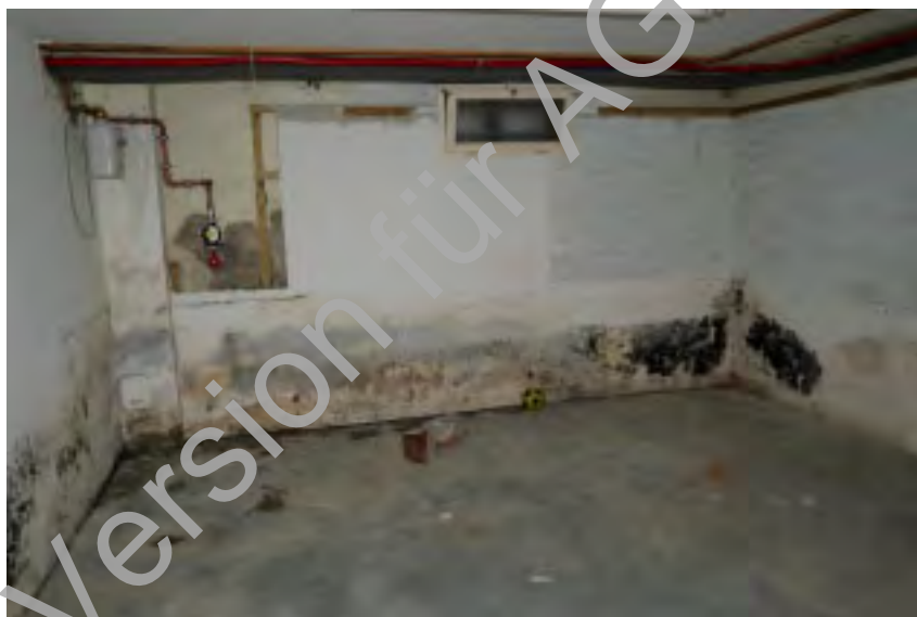
Keller 2 Kellergeschoss (Wohnhaus LP Nr. 1) mit starkem Schimmelschaden
