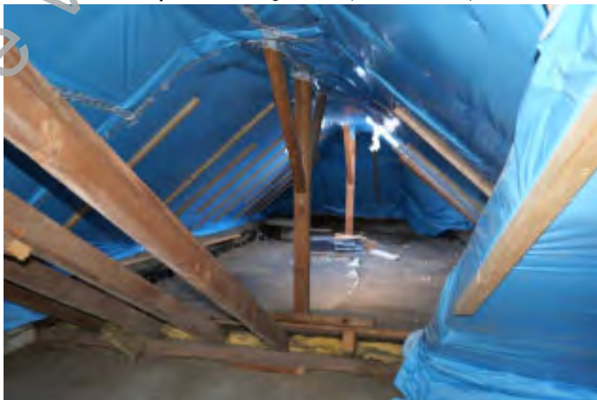
Speicher Dachgeschoss (Anbau LP Nr. 3)
