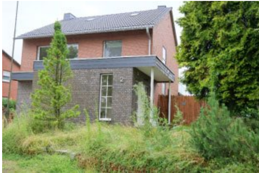
Straßenansicht (Wohnhaus LP Nr. 1, Eingangsanbau 2)
