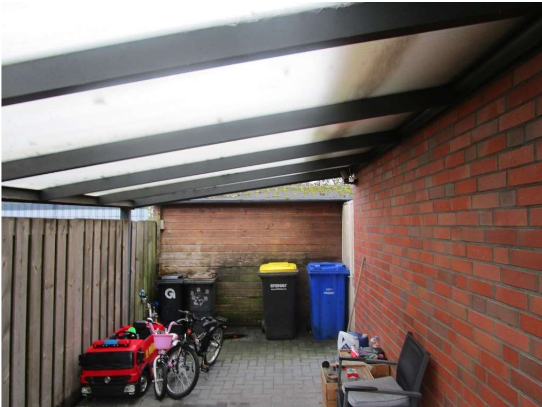
Abstellraum mit Überdachung
