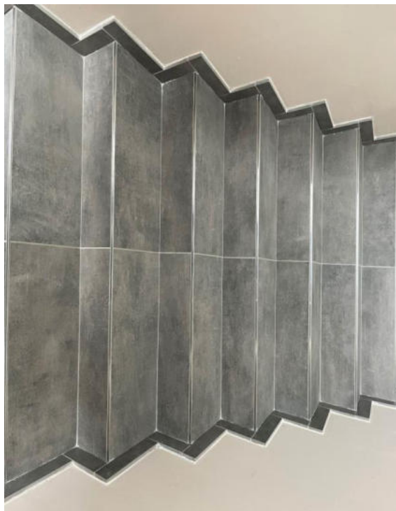
Treppe vom EG in das DG
