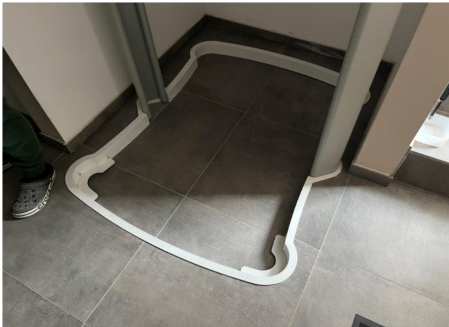
Aufzugsunterfahrt im EG
