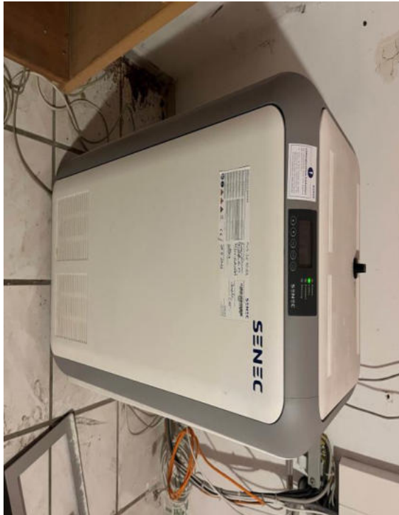
Batteriespeicher mit Wechselrichter
