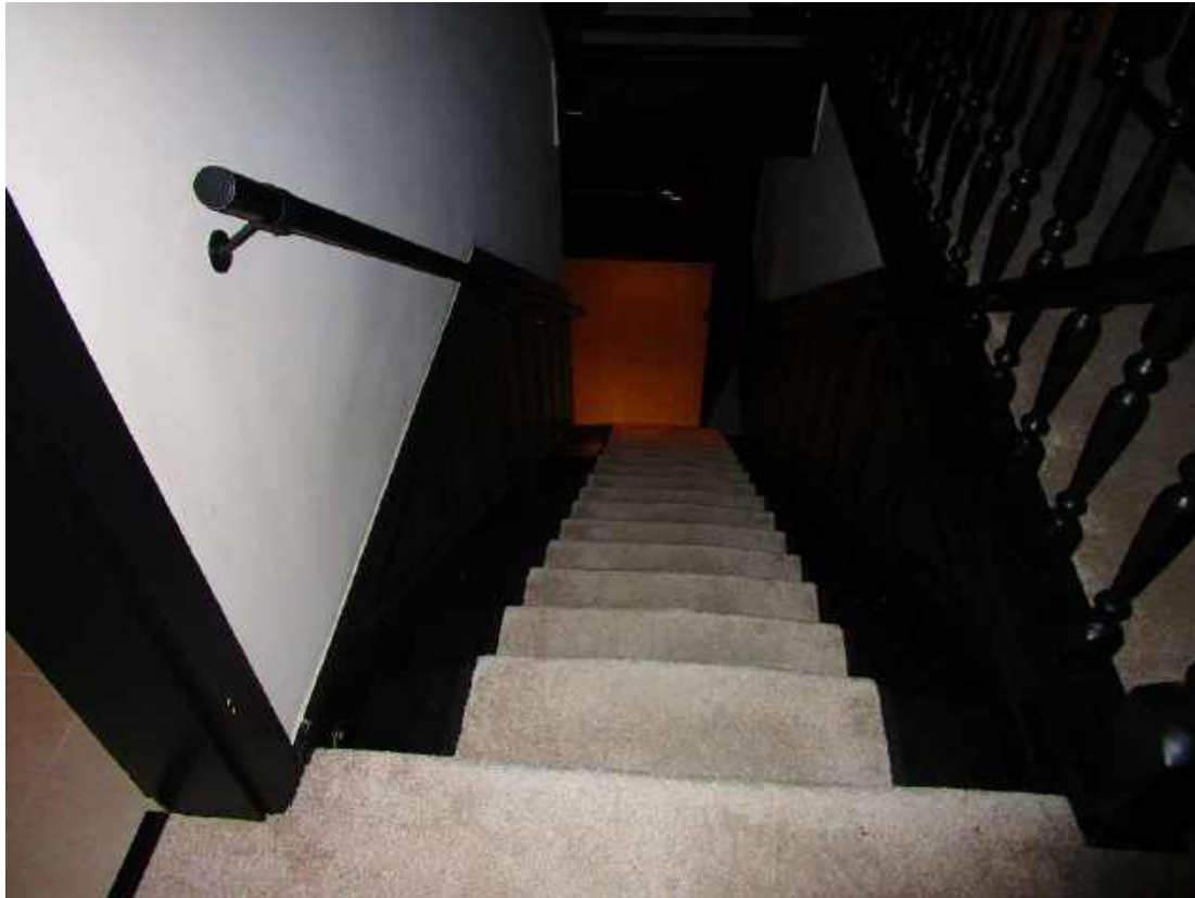
Treppenaufgang zum Dachgeschoss
