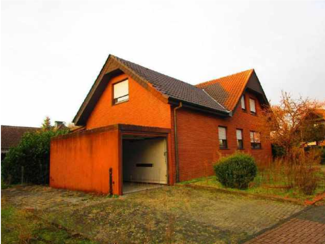
Seitenansicht mit Fertiggarage
