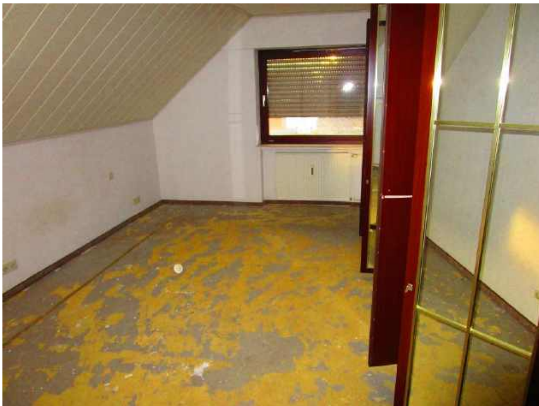
Kinderzimmer im Dachgeschoss
