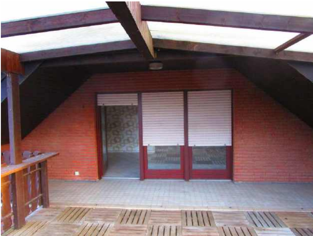
Dachterrasse im Dachgeschoss
