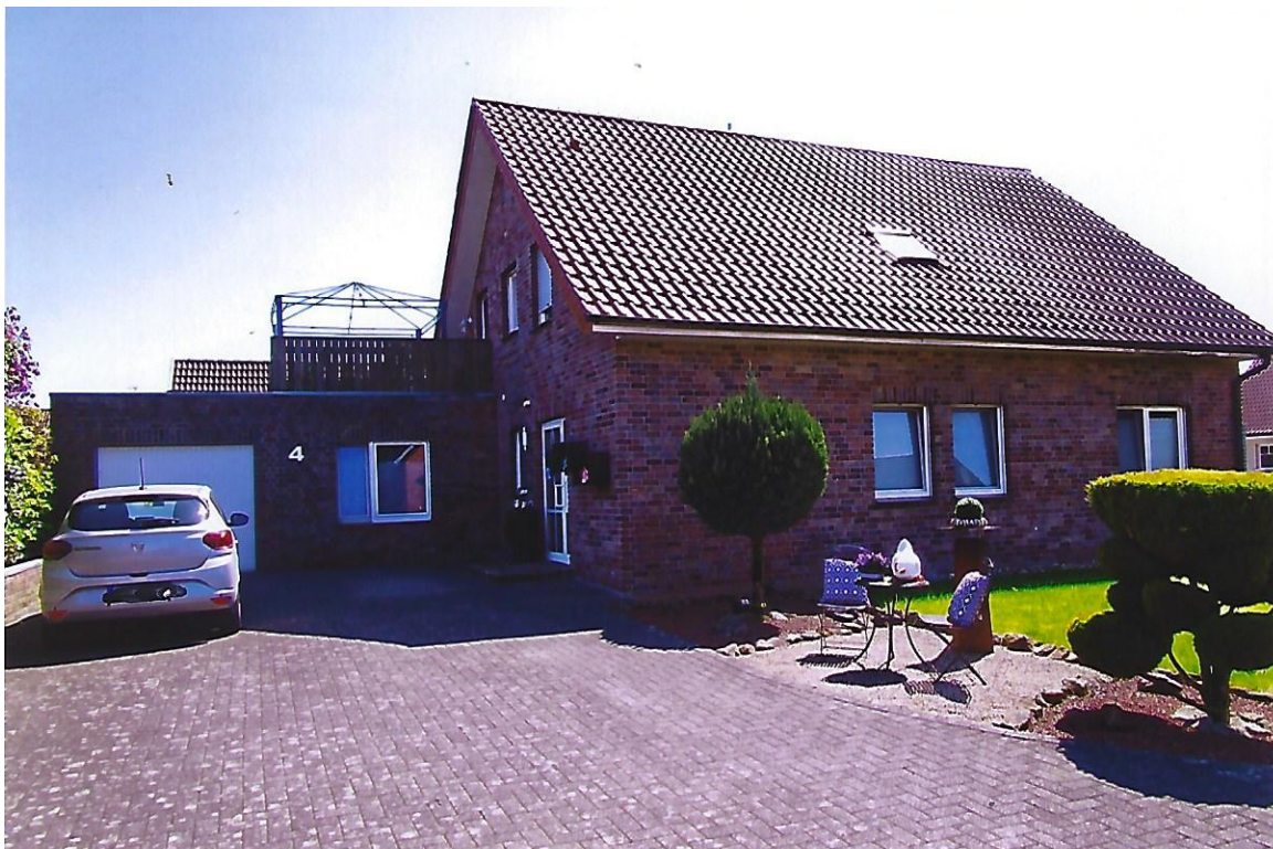
Im Bild der Blick aus Nord- Nordwest auf die Liegenschaft
