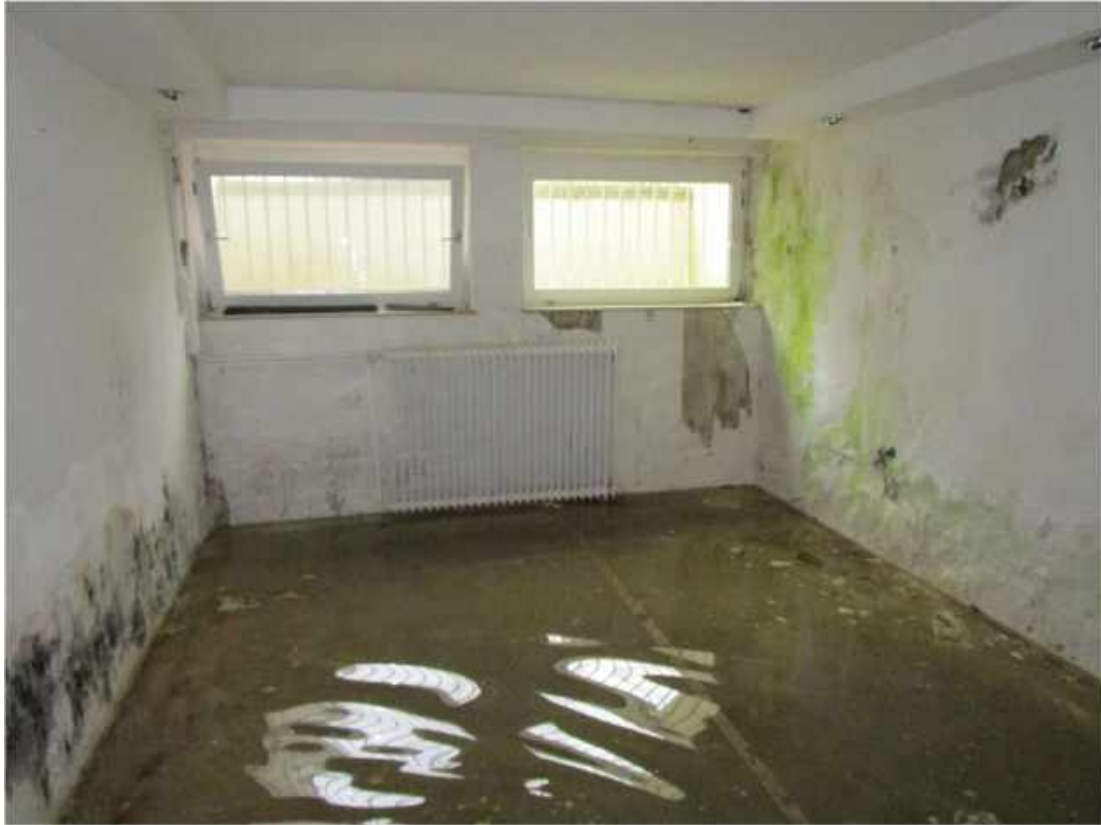
Wohnzimmer Kellergeschoß ( Haushaltshilfe ) mit Wassereinbruch und Schimmelbefall
