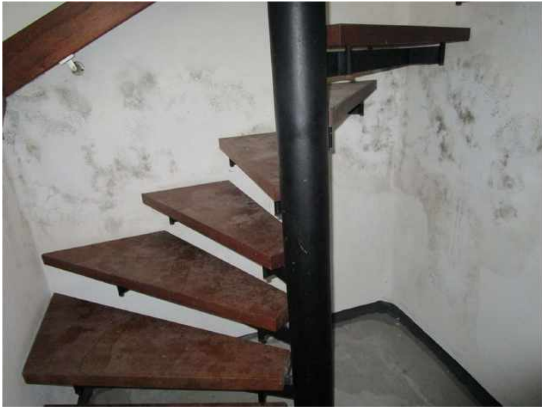
Wendeltreppe zum KG mit Feuchtespuren an der Wand
