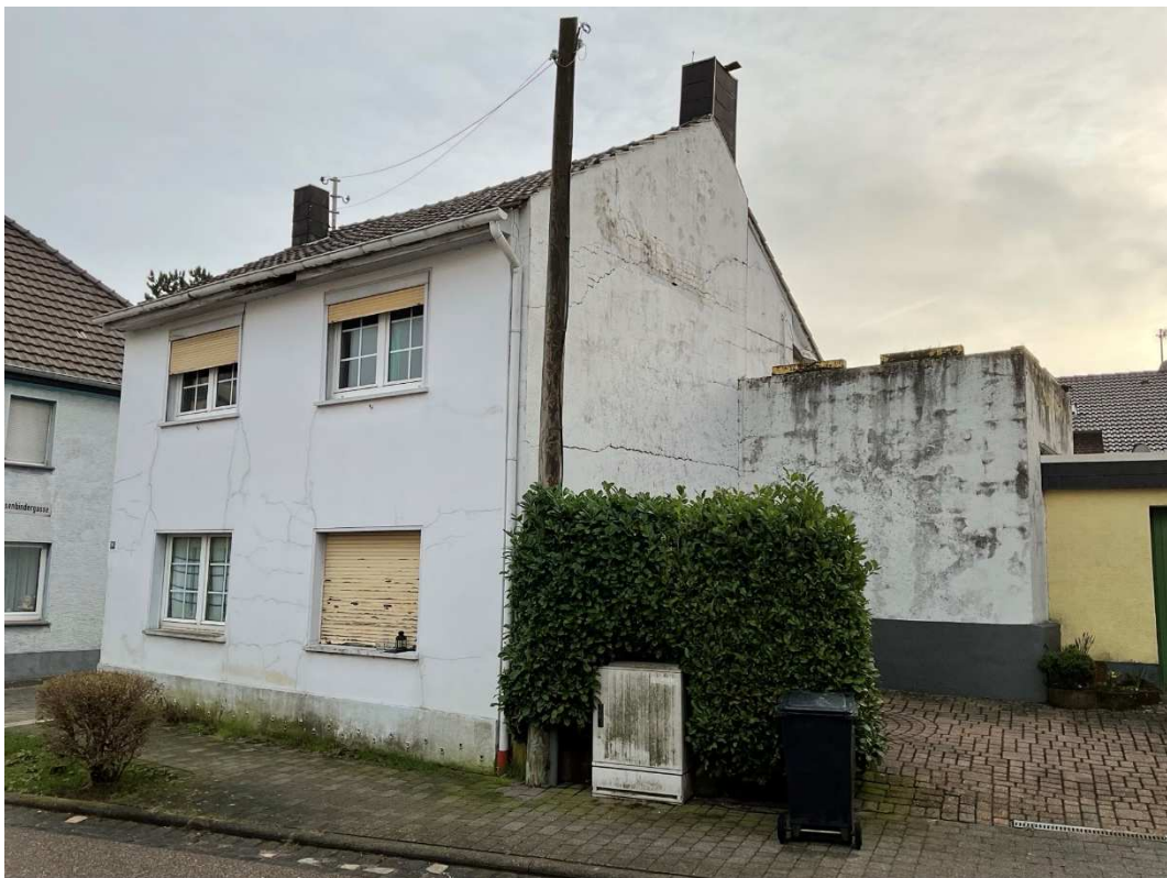
Bild 1: Profilsicht Wohnhaus mit Nebengebäude 1
