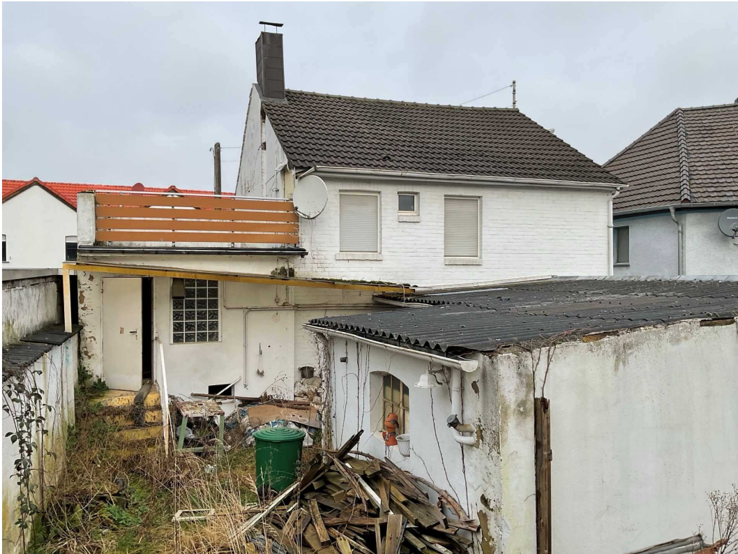
Bild 4: Rückansicht Wohnhaus mit Nebengebäude 2
