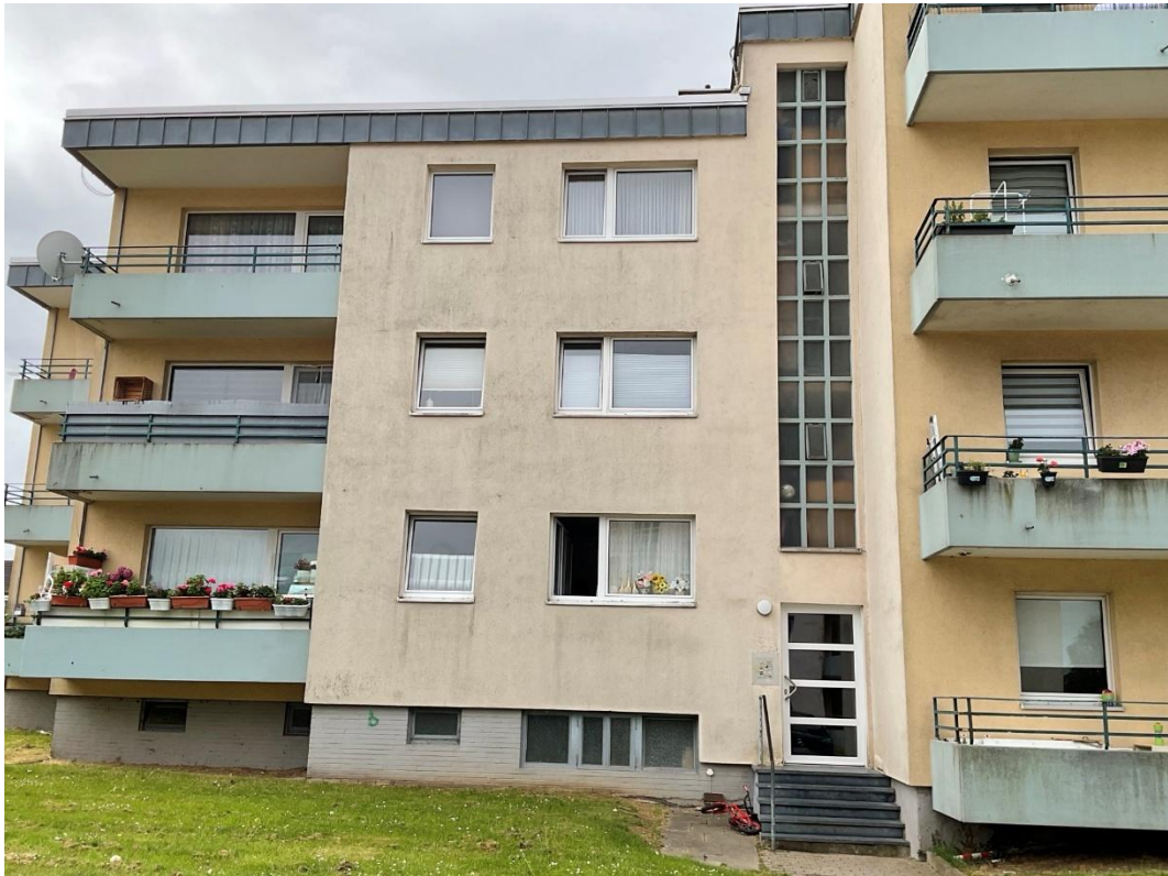
Bild 4: Seitansicht mit Hauseingang
