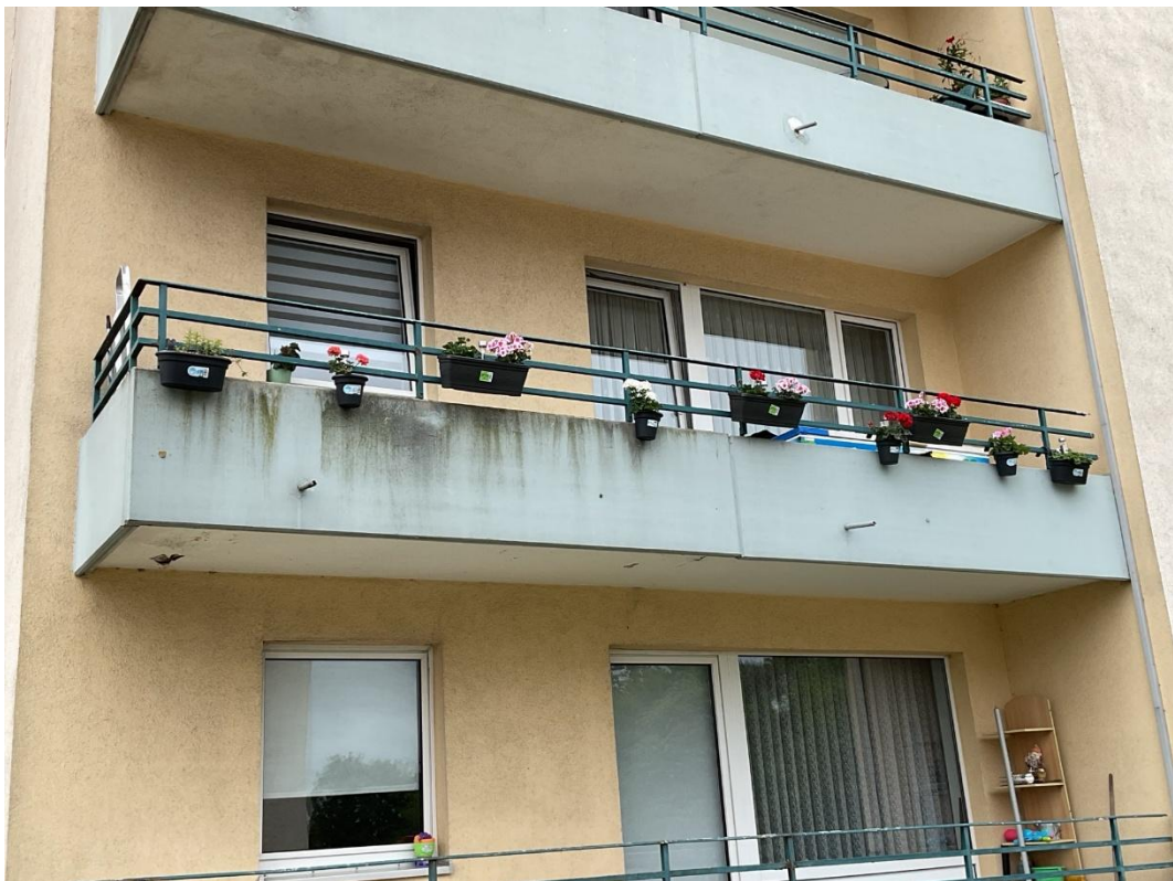
Bild 5: Balkon zu Wohnung 10
