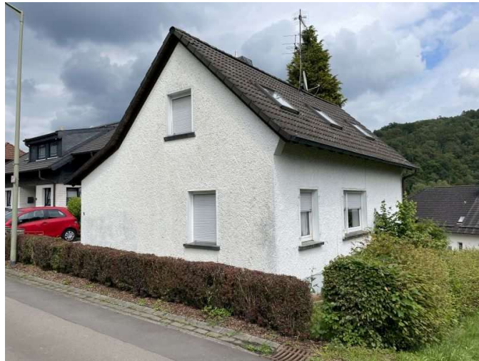
Wohnhaus Alte Wiese 4 - Ansicht von der Straße Alte Wiese
