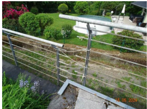
Bild 26 Geländeranschluss fehlt
