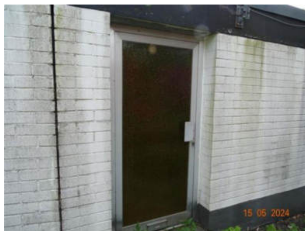
Bild 34 Nebeneingang zur [C] Garage
