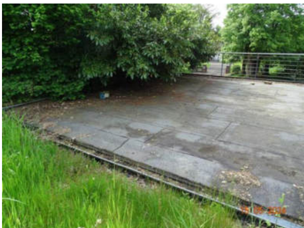
Bild 27 Abläufemüssen gereinigt werden
