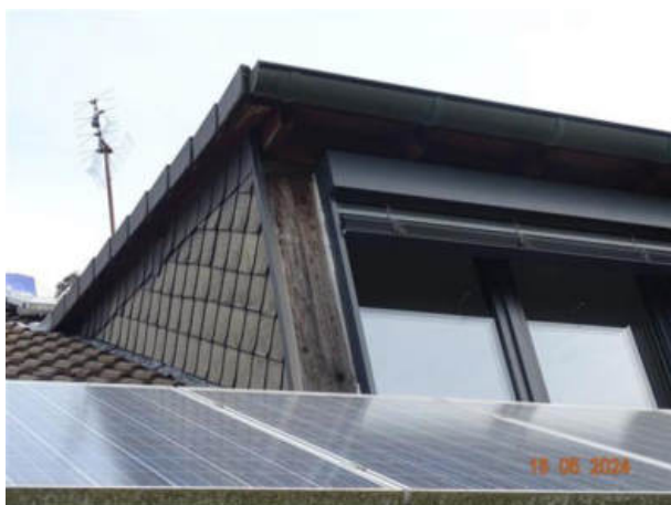
Bild 31 Holzwerkankstrich muss überarbeitet werden
