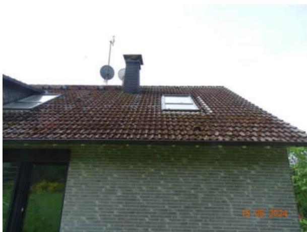
Bild 15 Dacheindeckung vermoost
