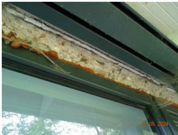
Bild 18 Sturzabdeckung fehlt
