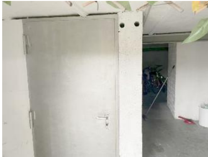
Kellerraum zur Wohnung Nr. 5 im DG und SB links
