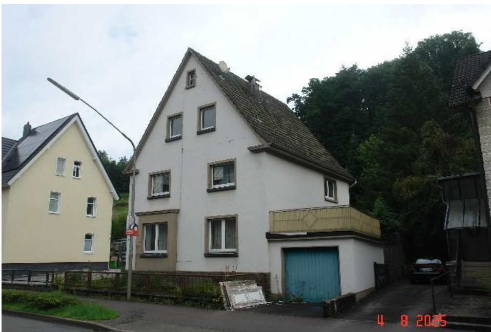
Bild 2: Ansicht des Bewertungsobjekts aus südlicher Richtung
