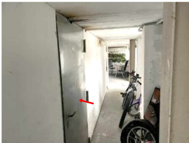
Kellerraum Nr. 6 zur Wohnung Nr. 6
