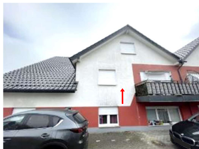
Wohnung Nr. 6 im Dachgeschoss und Spitzboden rechts
