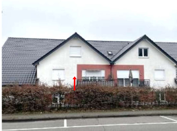
Mehrfamiliendoppelhaus Südring 7, 7 a
