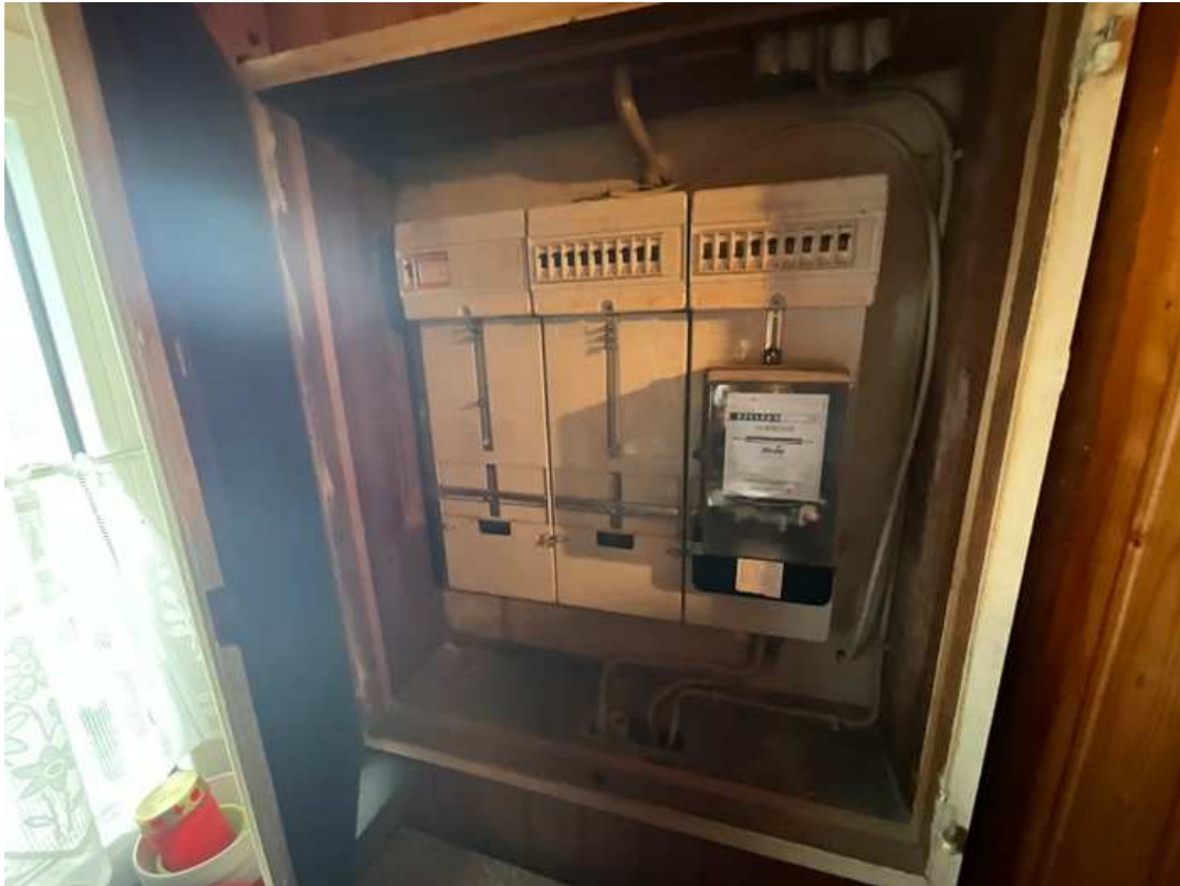
Bild 9 - Sicherungskasten
