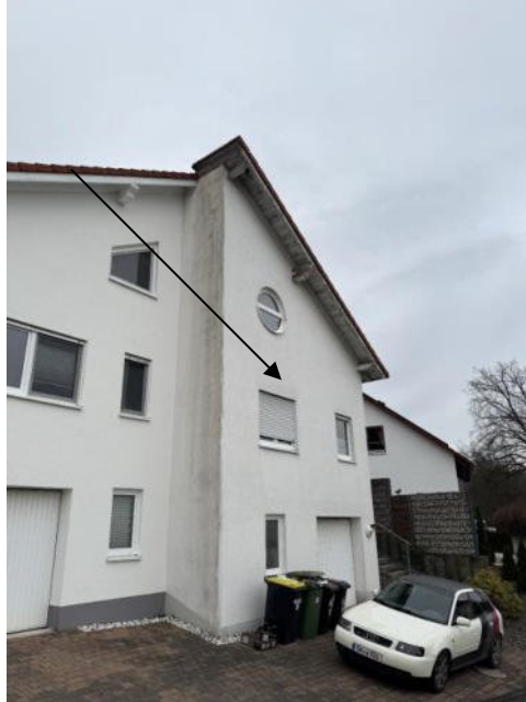
Bild 5: Ansicht des Bewertungsobjekts aus südlicher Richtung
