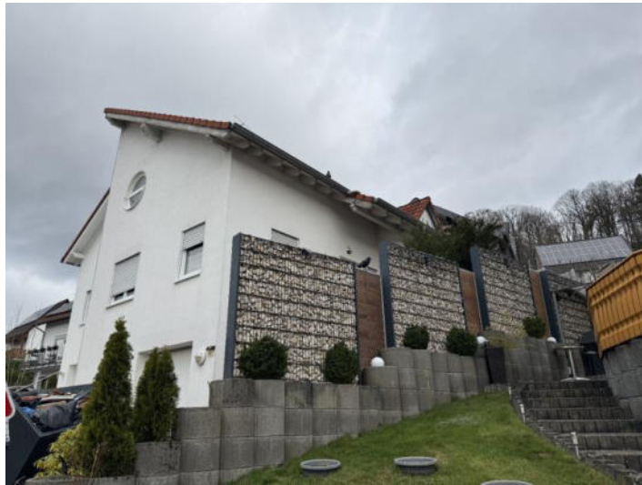
Bild 1: Ansicht des Bewertungsobjekts aus südöstlicher Richtung
