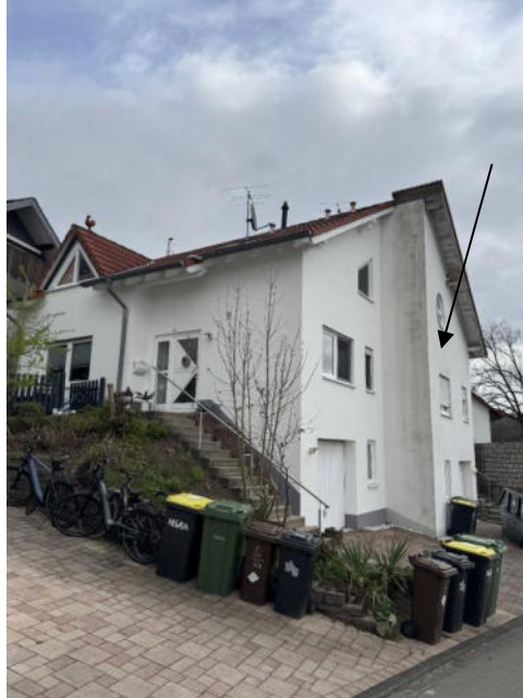
Bild 3: Ansicht des Bewertungsobjekts aus südwestlicher Richtung
