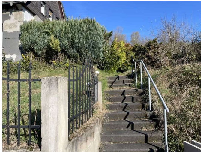
Treppe zum Hauseingang
