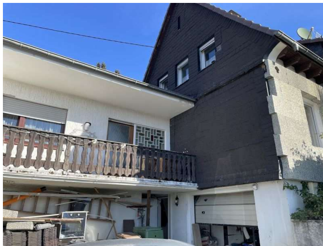
Südwestansicht mit Kellergarage
