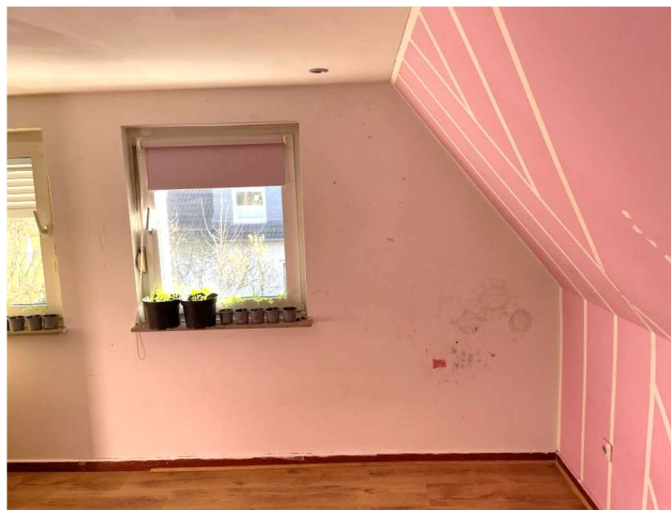
Zimmer im Dachgeschoss
