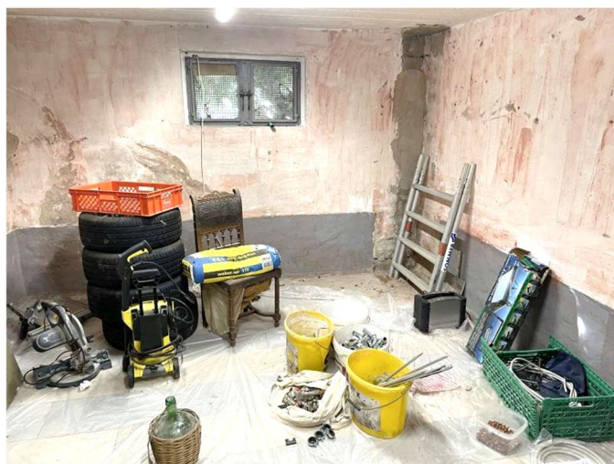
Raum im Kellergeschoss
