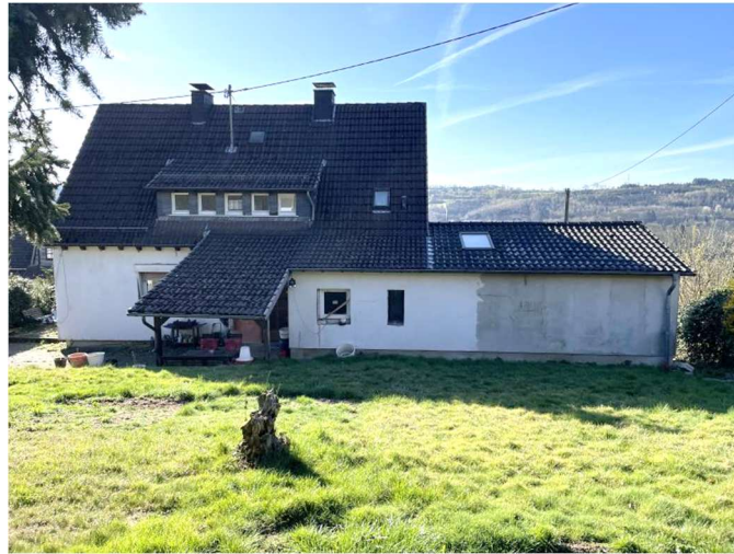
Rückwärtige Ansicht (Nordwestansicht) mit Flurstück 1621
