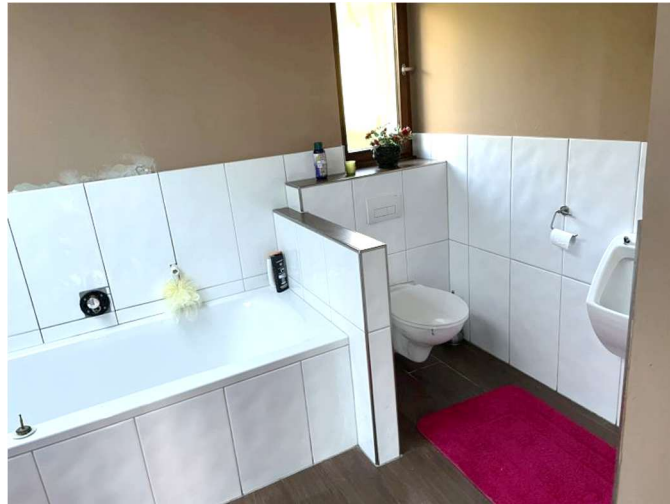
Renoviertes Bad im Erdgeschoss
