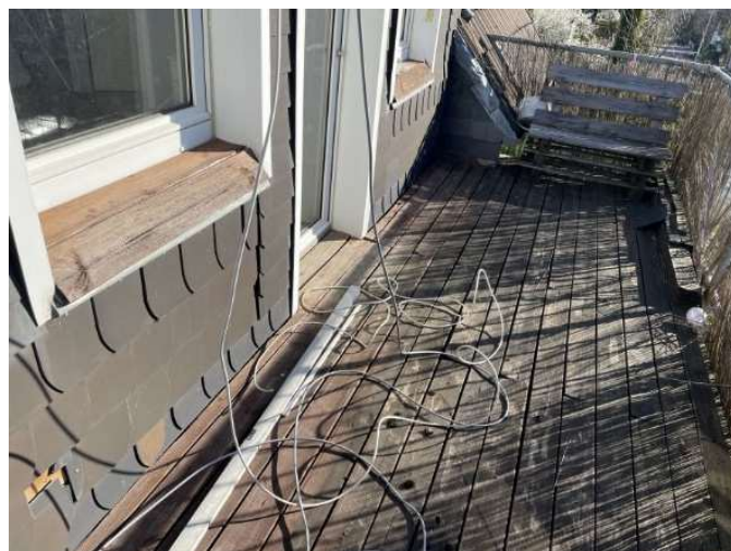
Balkon im Dachgeschoss
