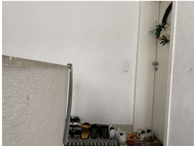
Eingangstür Wohnung Nr. 7 im Dachgeschoss rechts
