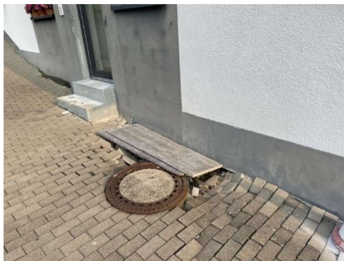
Abgesacktes Betonsteinpflaster
