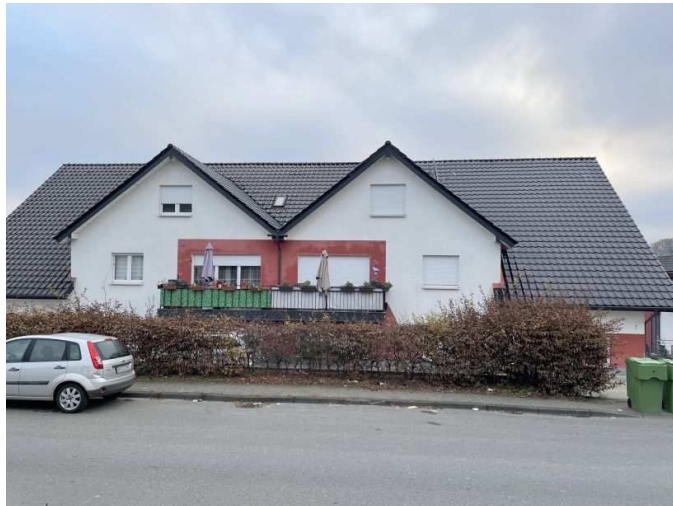
Mehrfamiliendoppelhaus Südring 7, 7a
