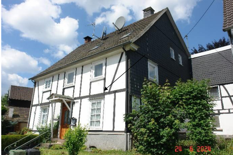
Bild 3: Ansicht des Bewertungsobjekts aus südöstlicher Richtung
