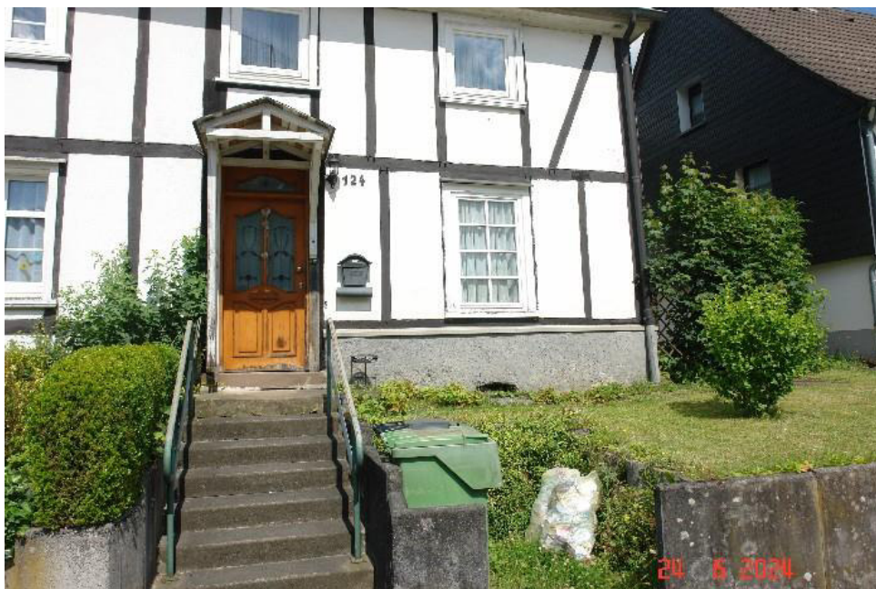
Bild 2: Ansicht des Hauseingangsbereichs
