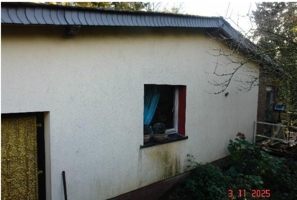
Bild 2: Ansicht des Bewertungsobjekts aus westlicher Richtung
