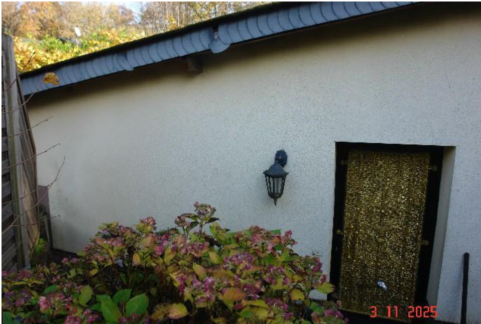
Bild 1: Ansicht des Hauseingangsbereichs
