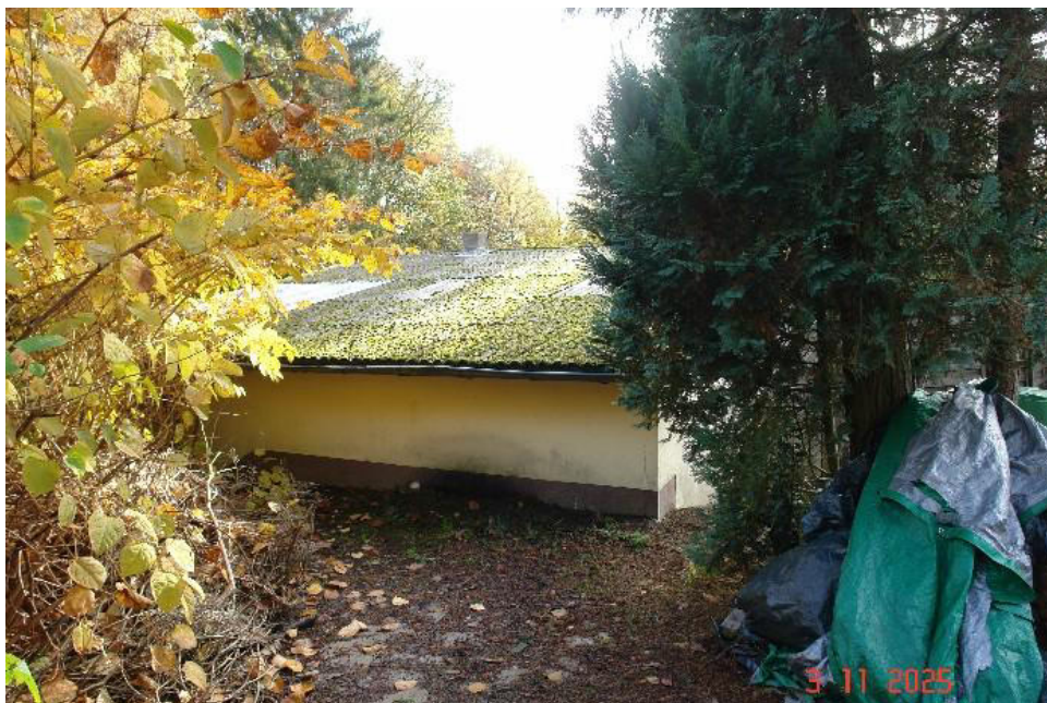
Bild 5: Dachfläche aus nördlicher Richtung
