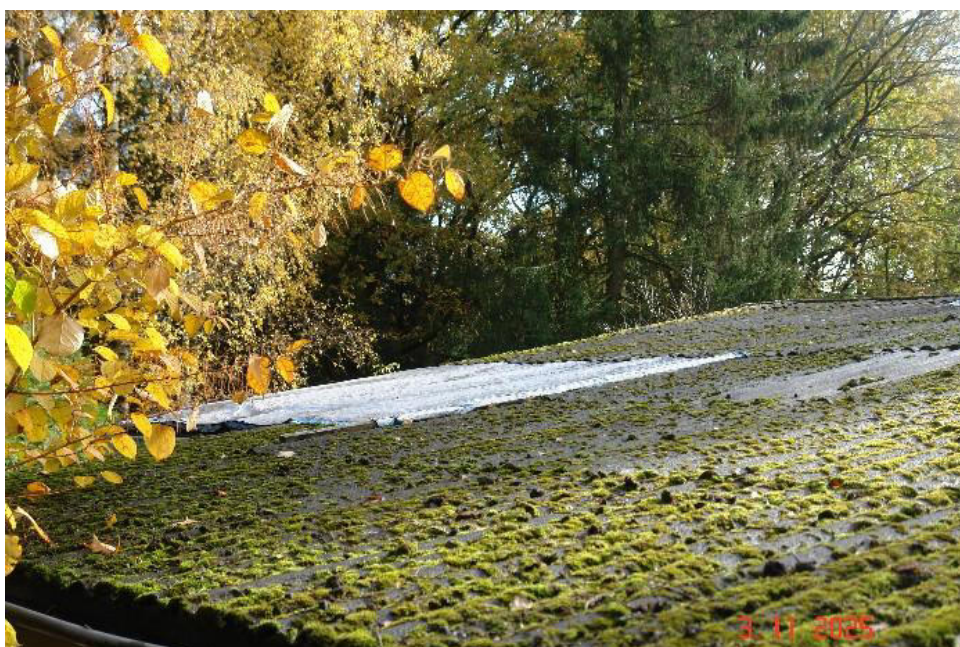
Bild 6: zu erneuernde Dachfläche
