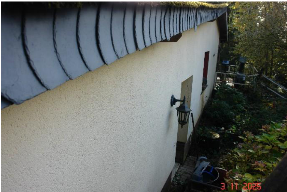
Bild 4: Ansicht des Bewertungsobjekts aus nördlicher Richtung
