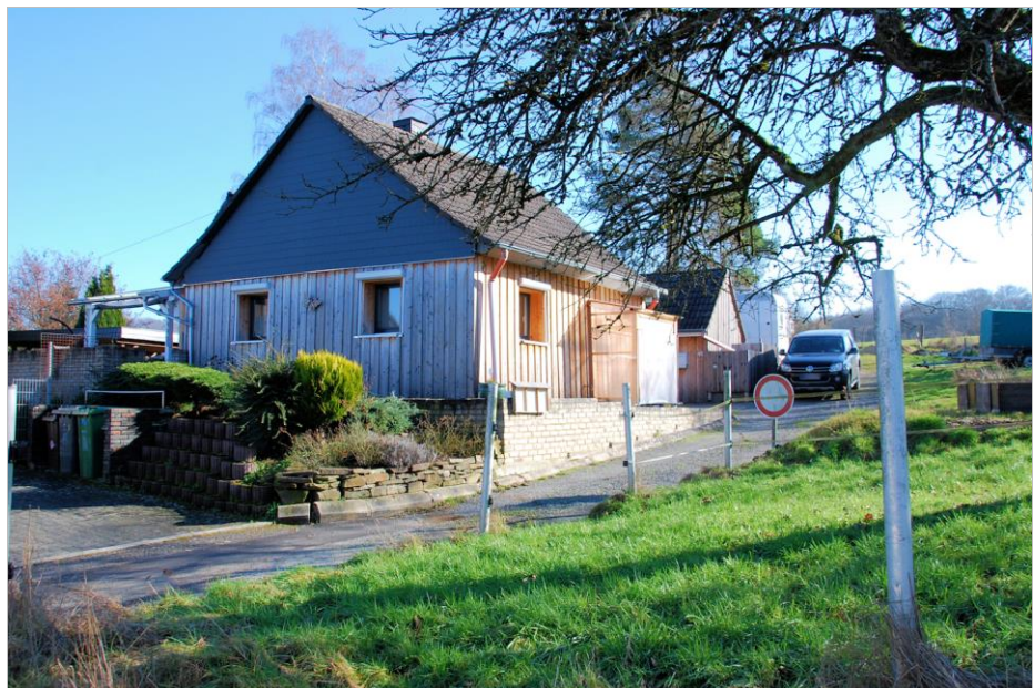
Abbildung 10 Unterbüchel 15, Ansicht von der Straße
