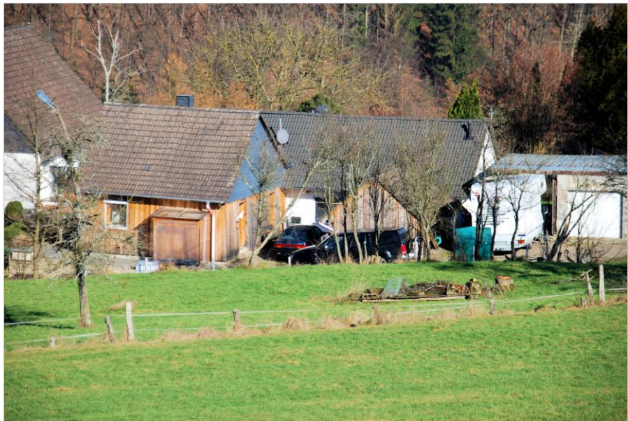
Abbildung 9 Unterbüchel 15, Ansicht der Südseite
