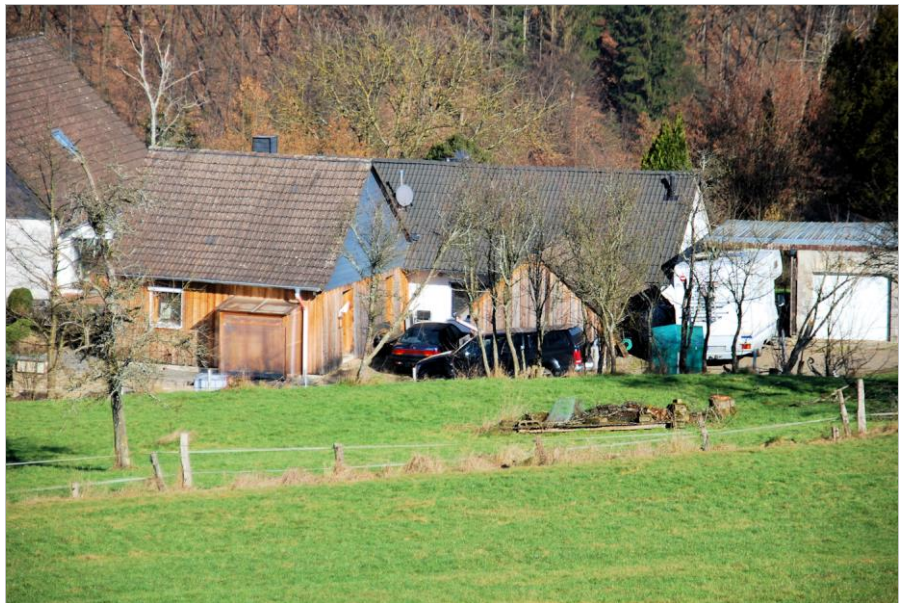
Abbildung 9 Unterbüchel 15, Ansicht der Südseite
