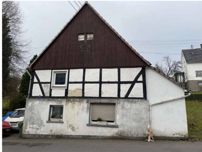
Einfamilienhaus Dürhölzener Straße 3 - Ostansicht
