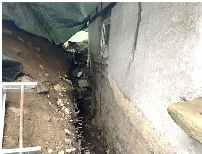
Ausschachtung auf der Südseite
