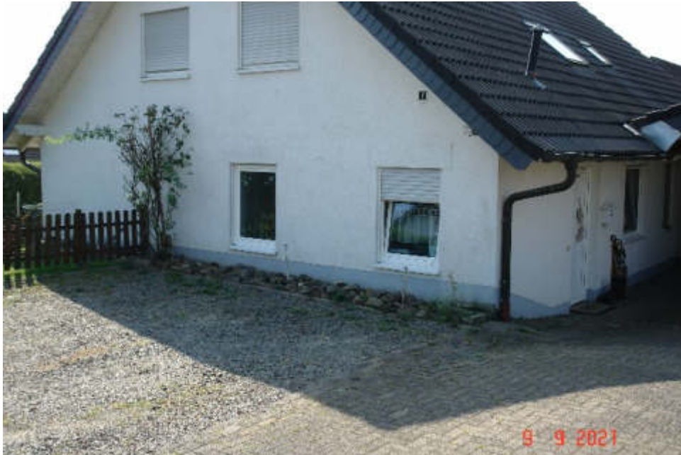
Bild 3: Ansicht des Bewertungsobjekts WE Nr. 1 im EG vorne
