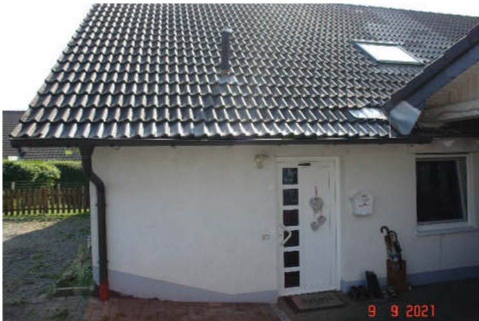
Bild 6: Ansicht des Hauseingangsbereichs
