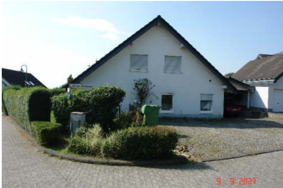
Bild 1: Ansicht des Bewertungsobjekts aus östlicher Richtung
