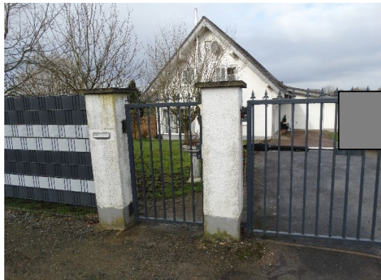
Ansicht von Südosten mit Zaun, Törchen und Tor
