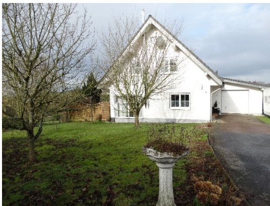
Ansicht von Südosten
